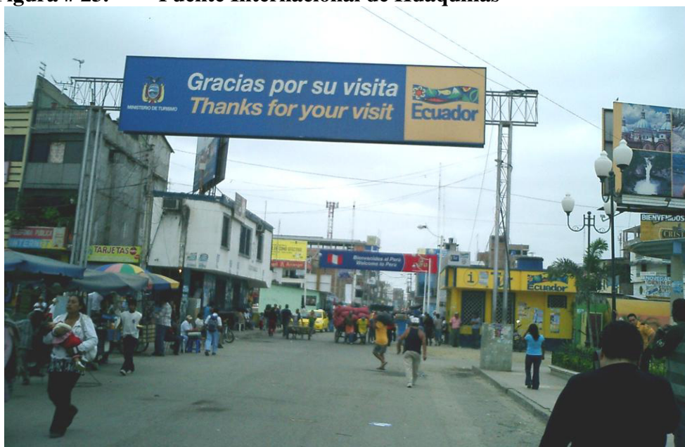
Figura # 23. Puente Internacional de Huaquillas
