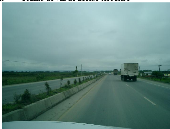
Figura # 21. Tramo de vía de acceso terrestre
