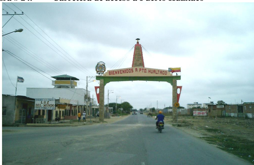
Figura # 24. Carretera de acceso a Puerto Hualtaco
