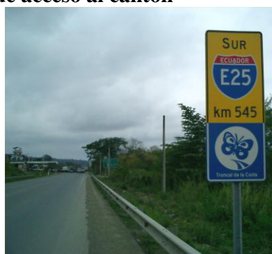
Figura # 20. Vía de acceso al cantón
