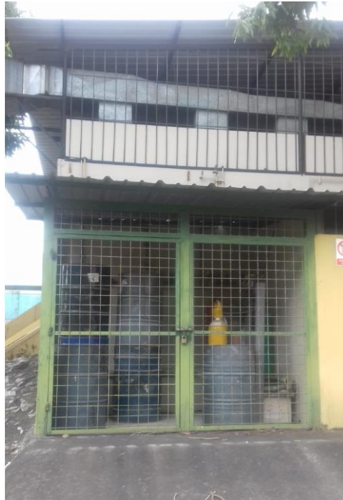
Cuarto de gases “vista frontal”
