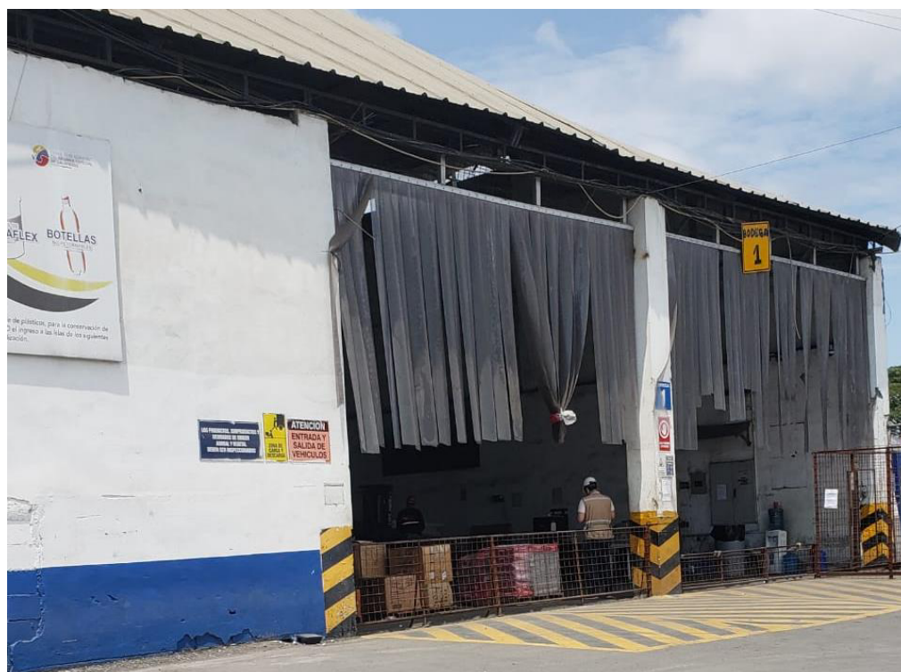
Imagen C-6 Bodega de almacenamiento.
