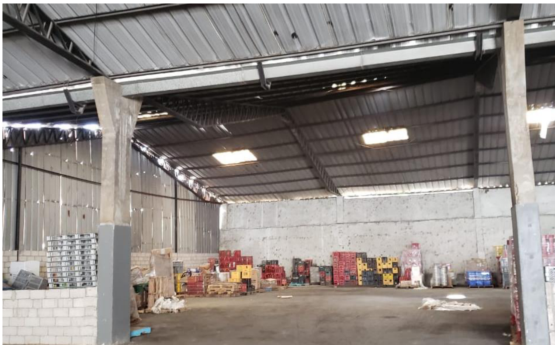
Imagen C-5 Productos almacenados en la bodega.
