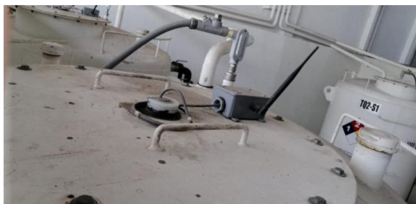
Figura 2.14 Instalación del sensor ultrasónico.
