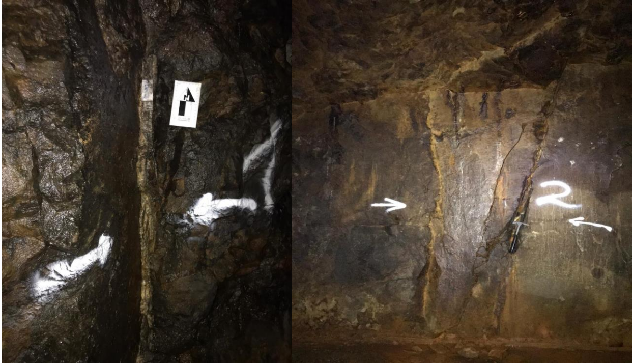
Ilustración 7.8 Estructura 1 y 2 (E1 y E2), en la segunda estructura existe una intersección de planos con la estructura 3, aproximadamente de una potencia de 10 cm.
