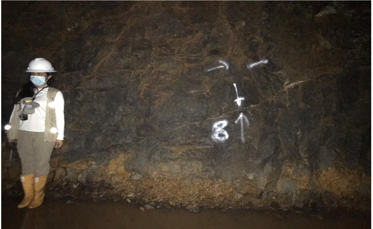
Ilustración 7.10 Falla Inversa (E8) en la pared izquierda a unos 50 m de la bocamina, en el techo se interseca con el plano de falla 9 (E9)
