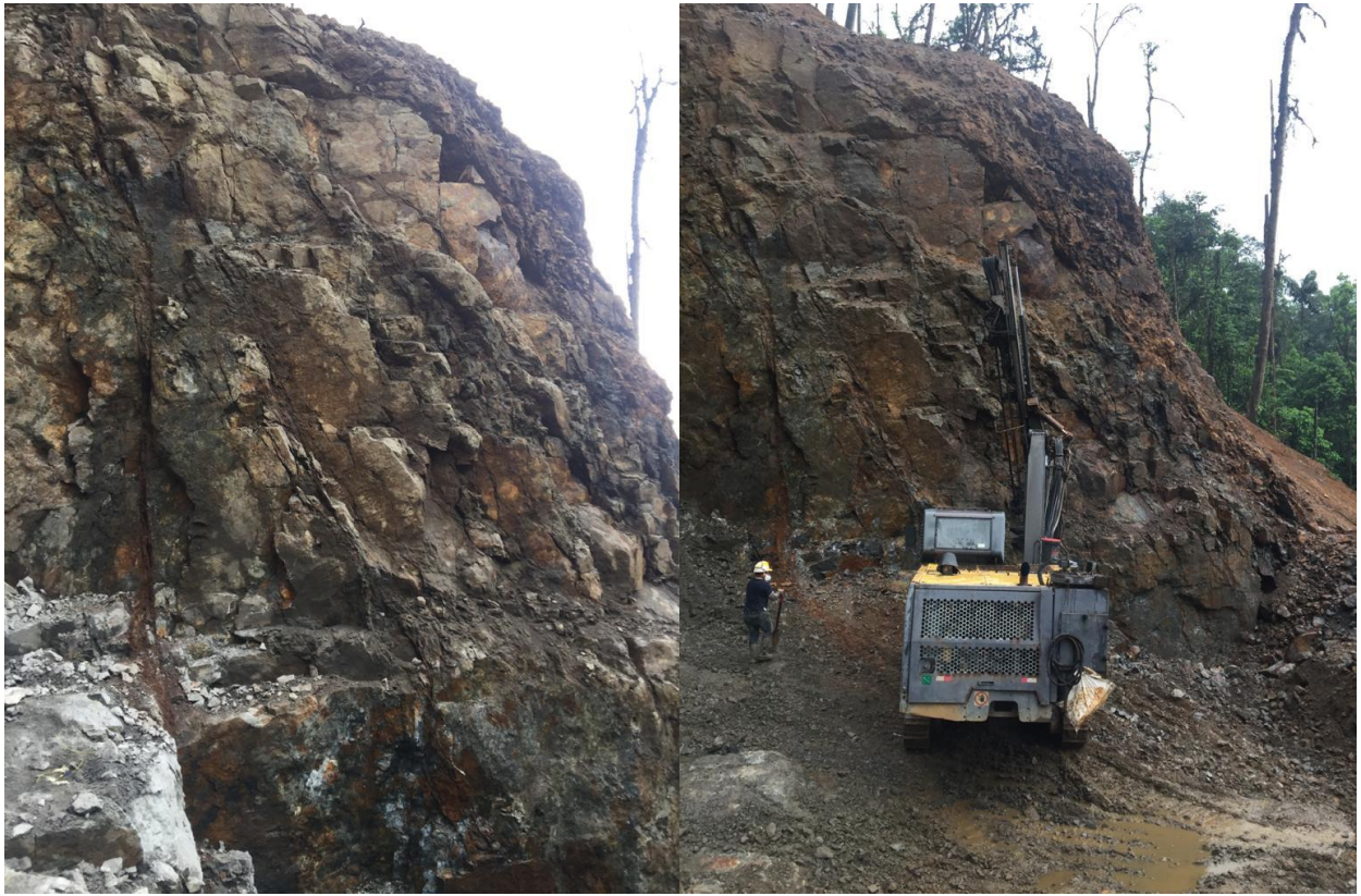
Ilustración 7.14 Perforación de Drill en zona altamente fallada.
