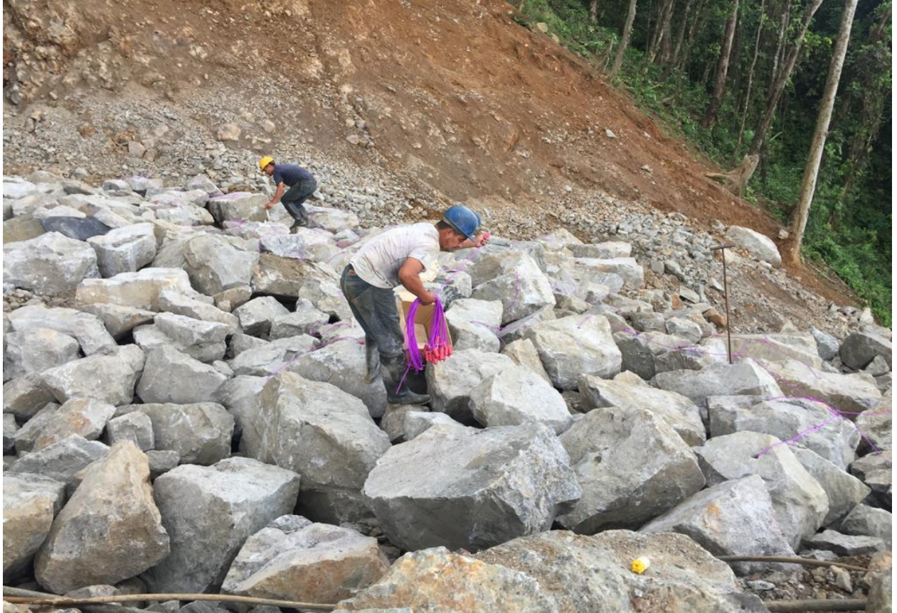
Ilustración 7.13 Voladura primaria y secundaria (rocas con sobretamaño).
