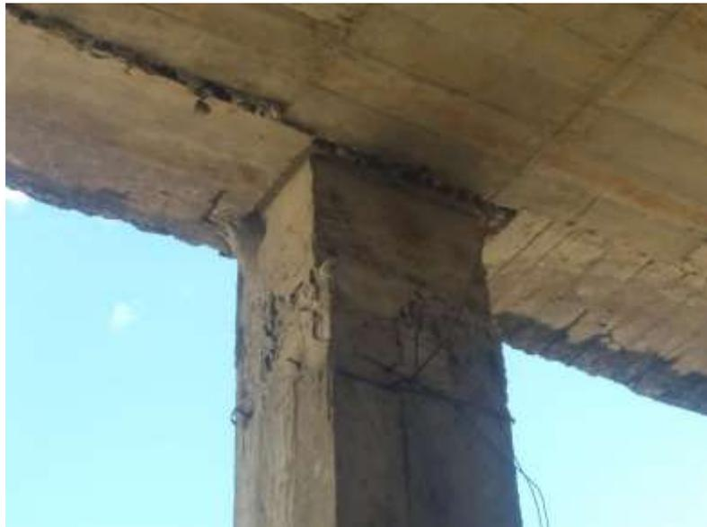
**Figura 2.22 Incorrecta metodología en realización de columnas. (Propia)**
