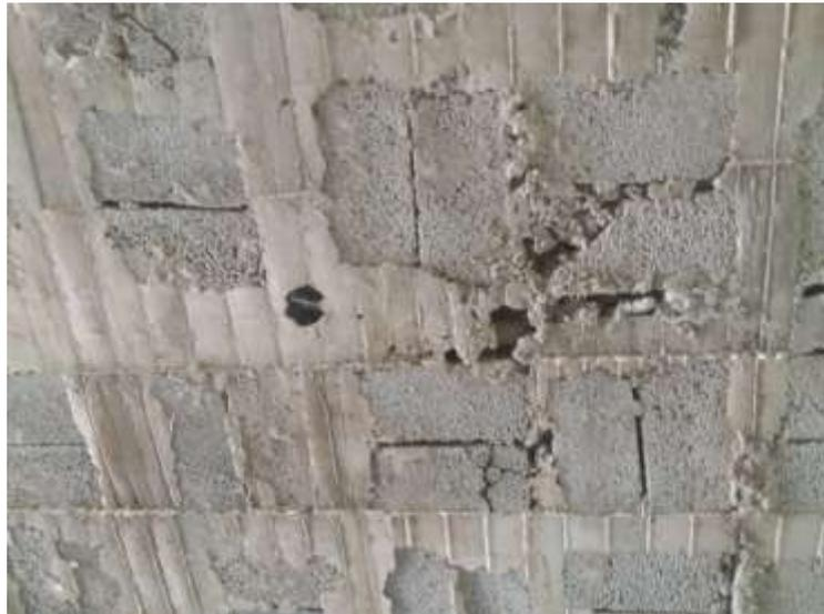
**Figura 2.20 Presencia de ratoneras en losa. (Propia)**
