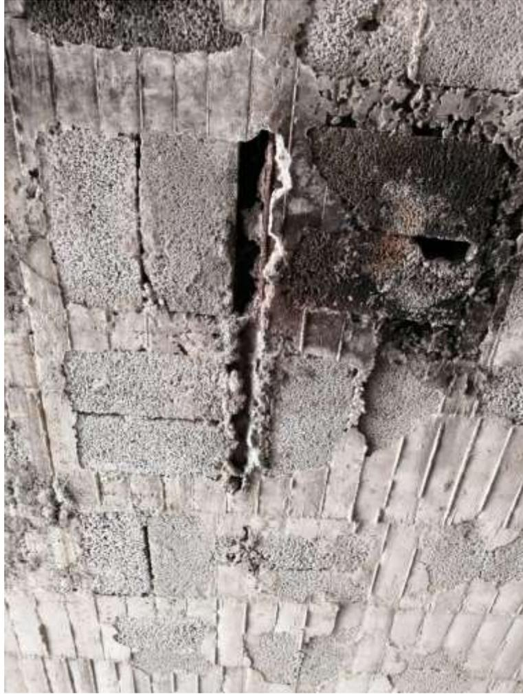
**Figura 2.21 Oxidación de acero estructural del nervio de la losa. (Propia)**
