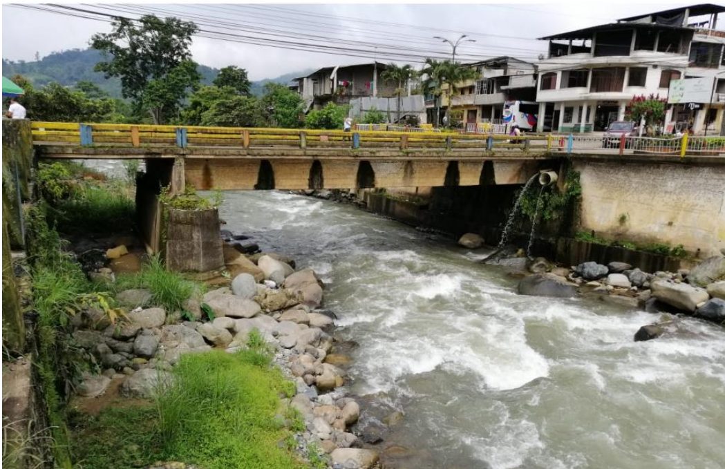
Figura 1.1 Puente de Caluma
