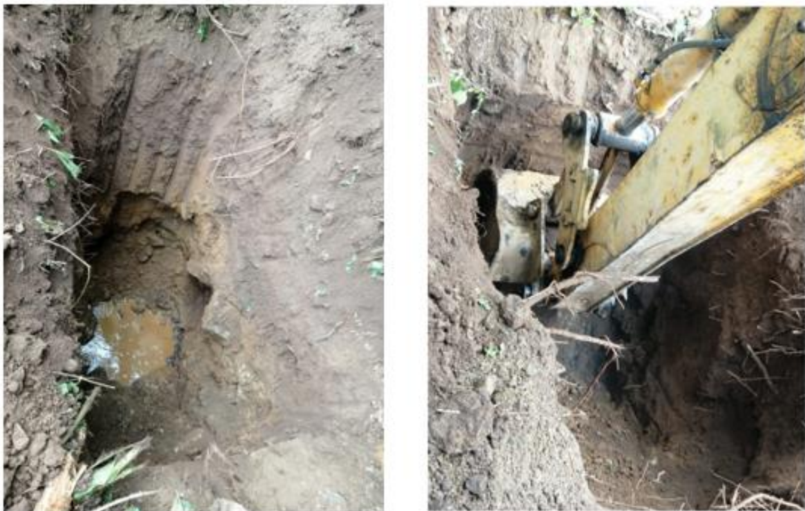
Figura 2.3 Calicata realizada en cercanías del Puente Metálico, Ciudad de Caluma.
