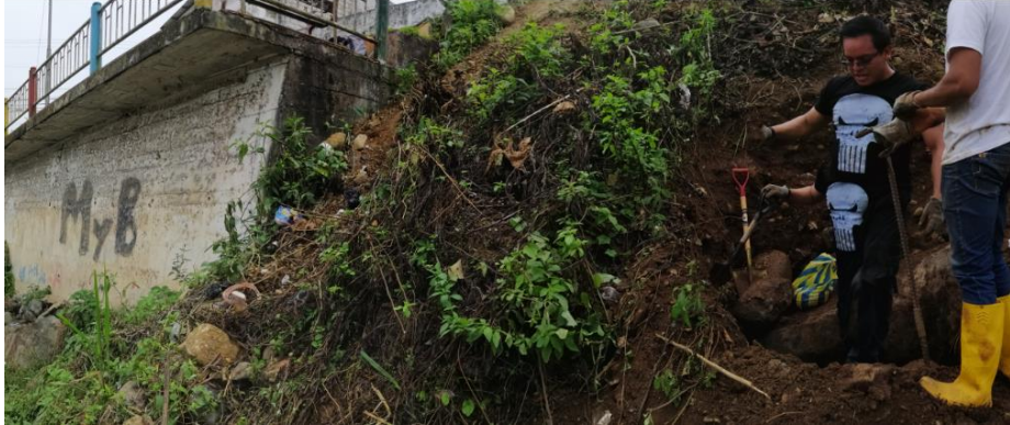
Figura 2.6 Lugar de extracción de las muestras del cementante
