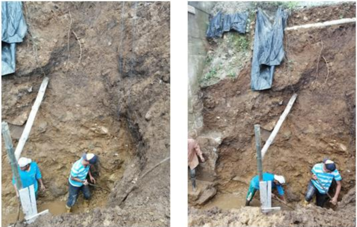
Figura 2.4 Extracción de muestra frente el puente Caluma, en la excavación realizada para la construcción de un muro estructural
