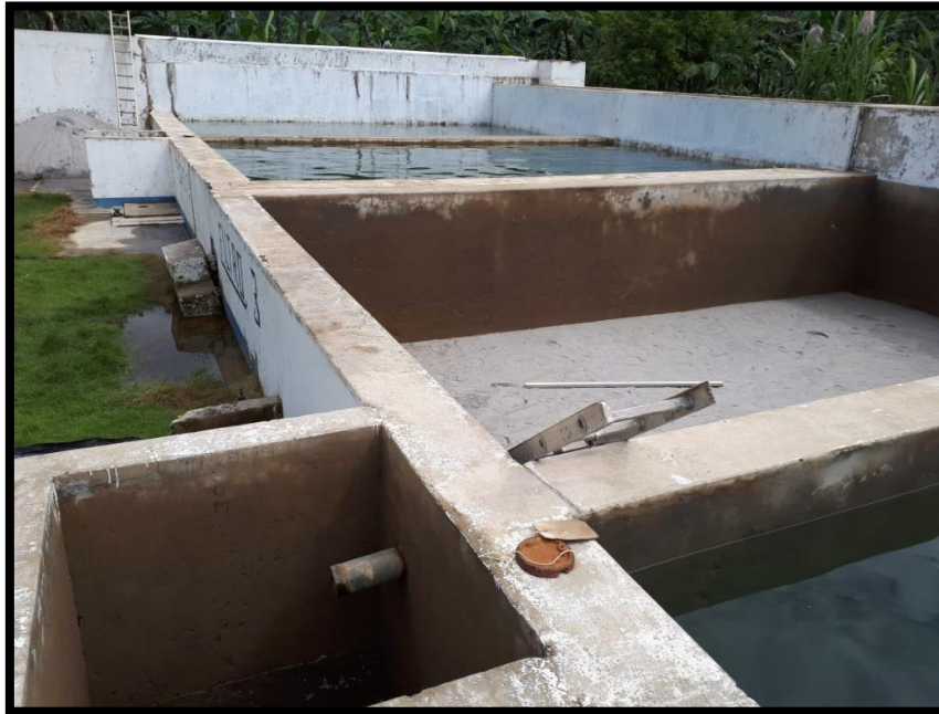
Gráfico 1.6 Modulo de filtración de la planta de Caluma Nuevo.
