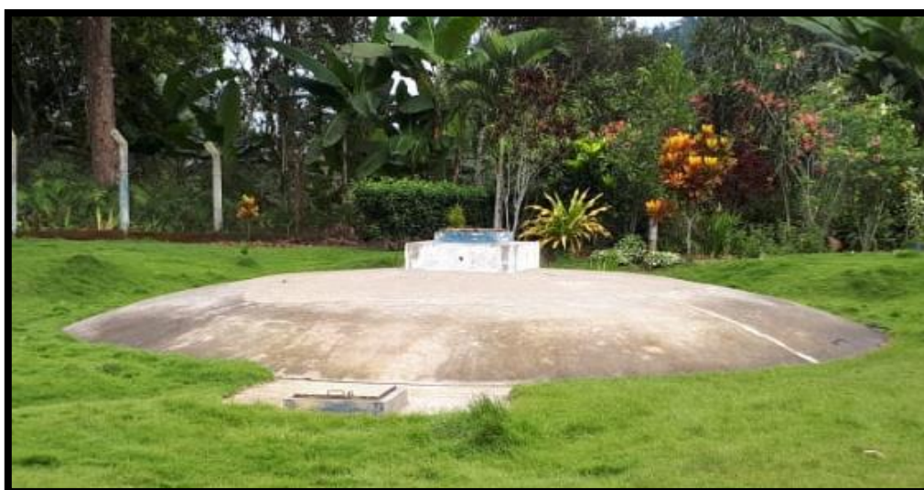
Gráfico 1.8 Tanque de almacenamiento de la planta de Caluma Nuevo.
