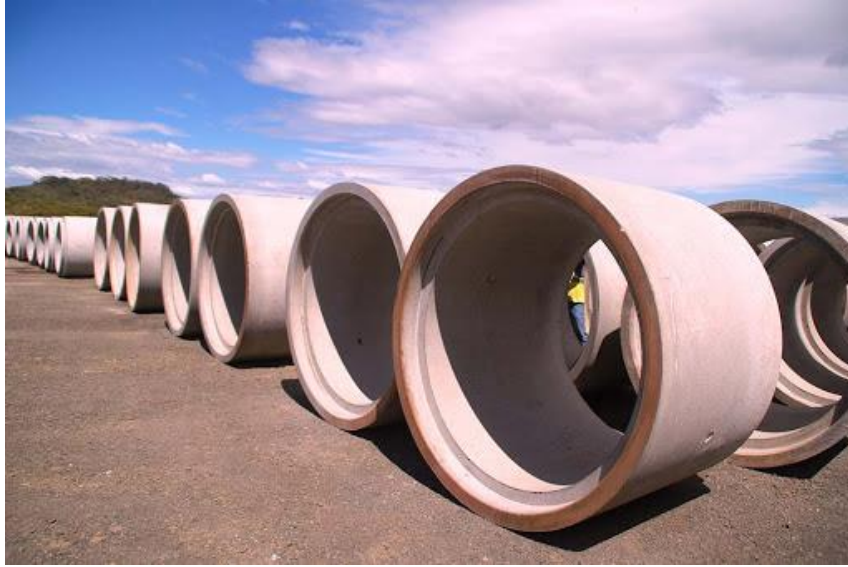
Figura 3-5 Almacenamiento lineal de tuberías de concreto (Concrenic, 2018).
