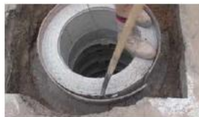
Retiro del encofrado
