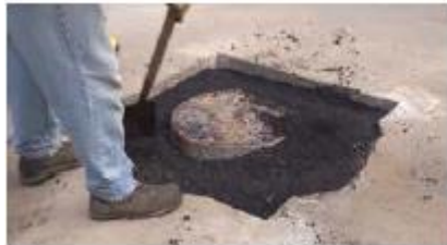
Colocación de tapa nueva
