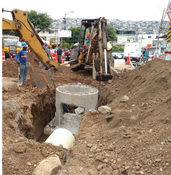
Figura 3-11 Mejoramiento local ubicado a un costado de excavación.
