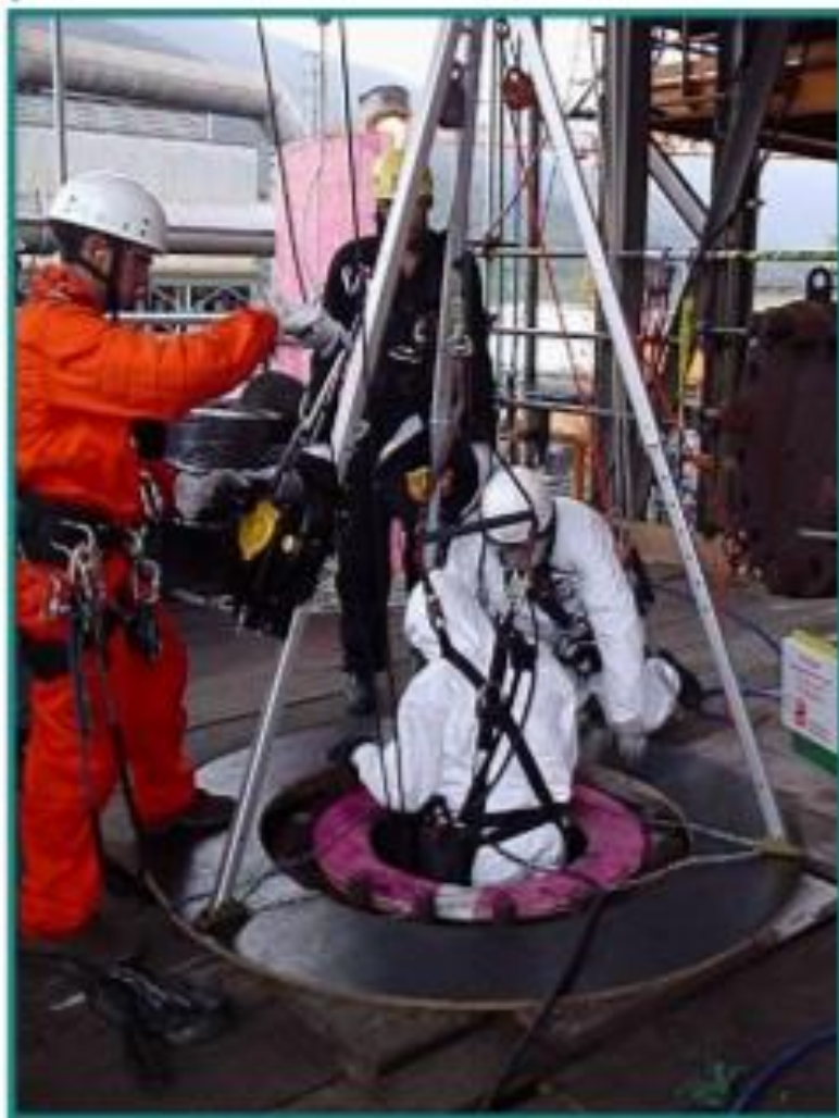
Figura 3-56 Uso de los equipos de protección personal en espacios confinados
