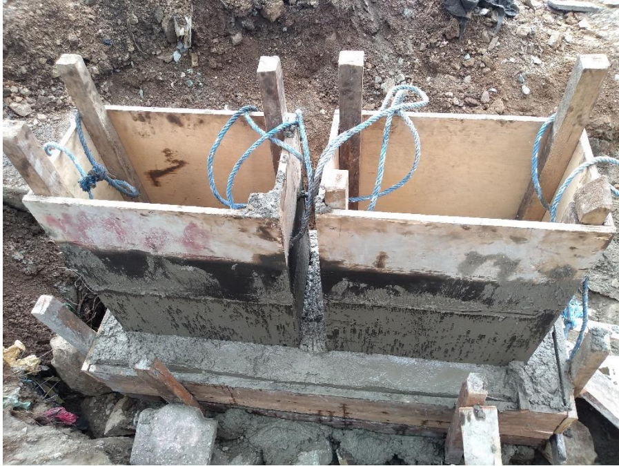
Figura 3-27 Encofrado para construcción de sumidero doble
