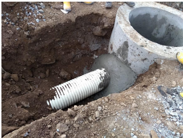
Figura 3-23 Conexión hermetizada cámara-ducto
