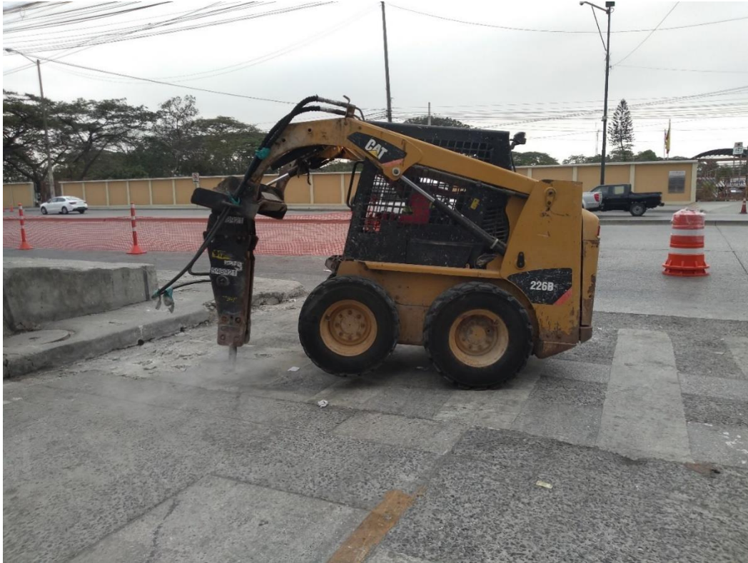
Figura 3-8 Rotura de pavimento con mini bobcat
