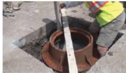
Colocación de tapa nueva
