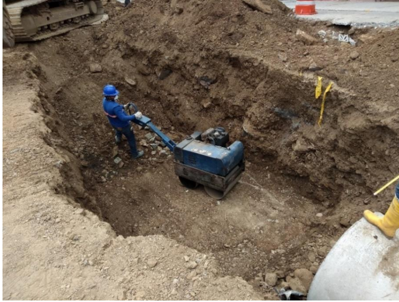
Figura 3-12 Compactación de fondo de zanja
