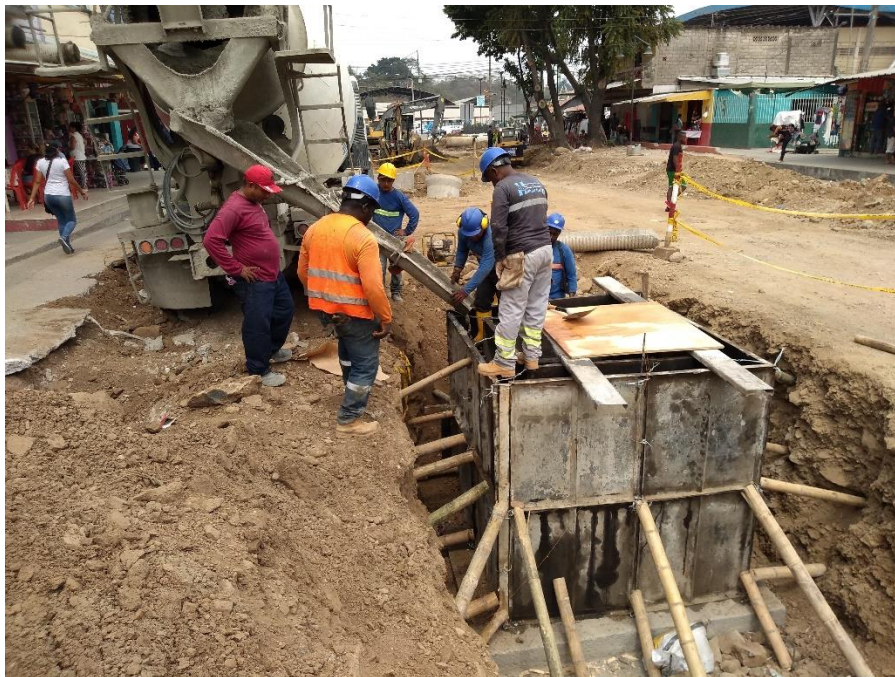
Figura 3-19 Encofrado y fundida de cámara de inspección
