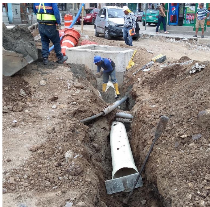
Figura 3-16 Acople manual de tubería usando barreta
