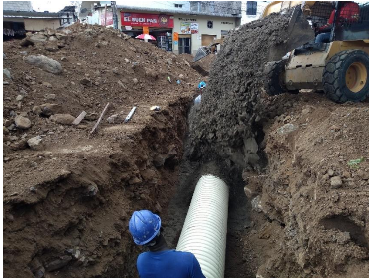
Figura 3-17 Relleno inicial para instalación de tubería PVC
