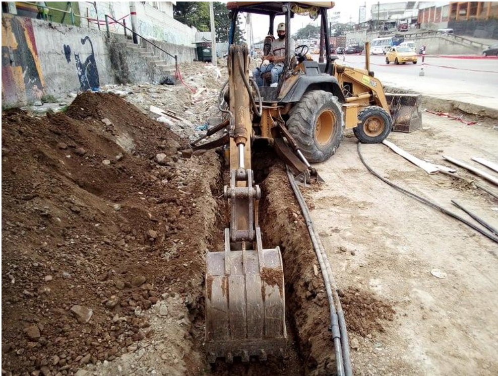
Figura 3-9 Excavación realizada con maquinaria
