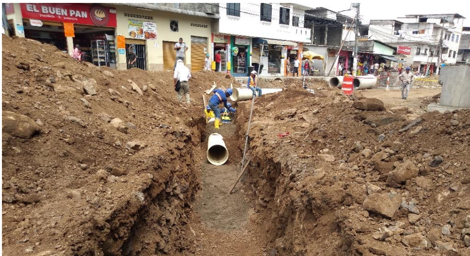
Figura 3-15 Tubería instalada sobre encamado de arena o replantillo
