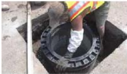
Colocación de tapa nueva
