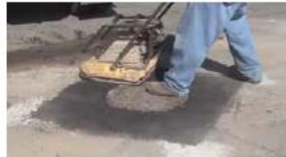
Restitución del pavimento
