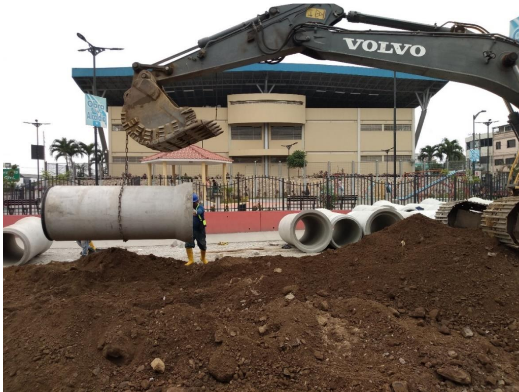
Figura 3-18 Descarga de tubería de hormigón
