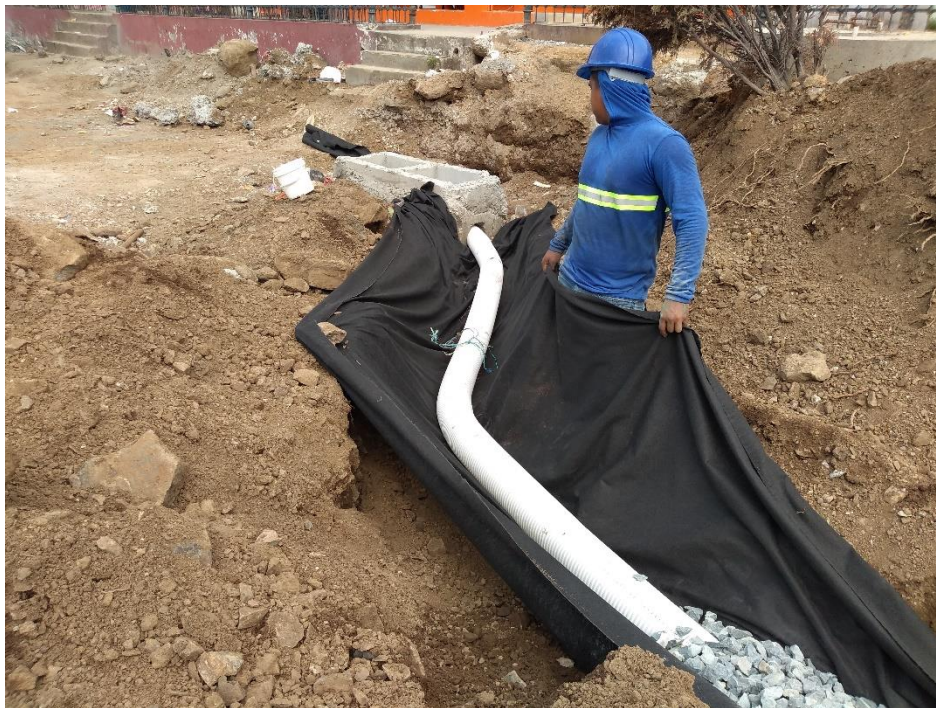
Figura 3-31 Instalación de dren y geotextil
