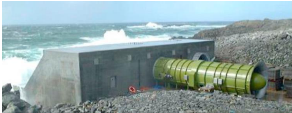
Figura 1.3 Planta de LIMPET OWC de 500 KW, instalada en el año 2000 en Islay, Escocia, Reino Unido. [Falcão & Henriques, 2016]
