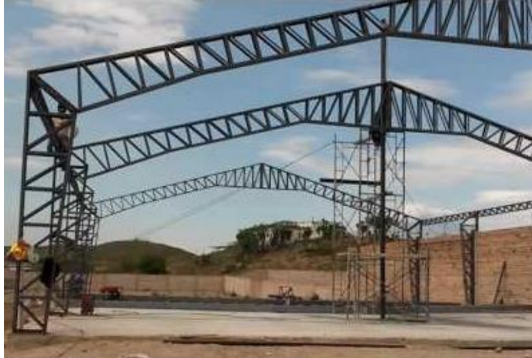
Figura 2.2 Armadura en celosía
