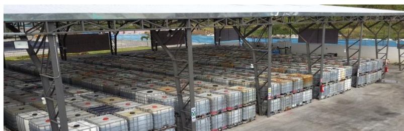
Imagen 16. Almacenamiento de la de sosa gastada en la REE
