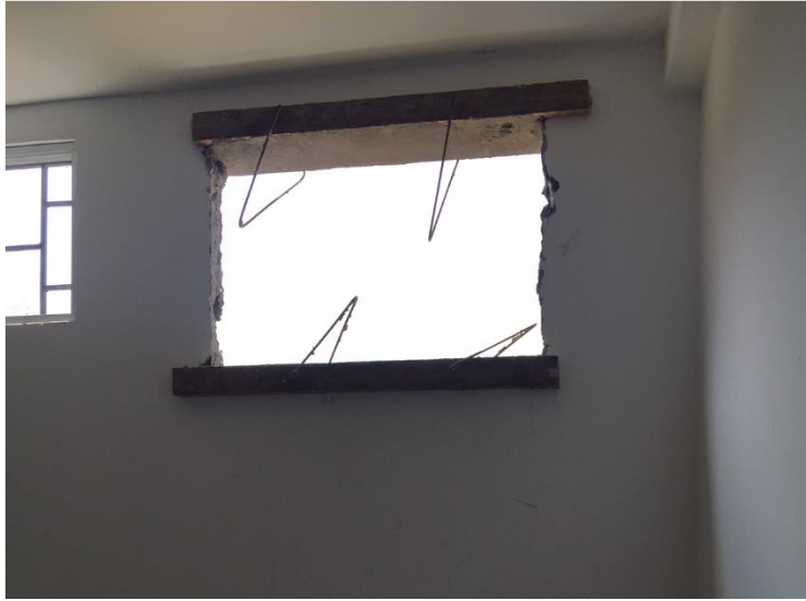
Ilustración 32.- Enlucimiento de Boquete del aire acondicionado
