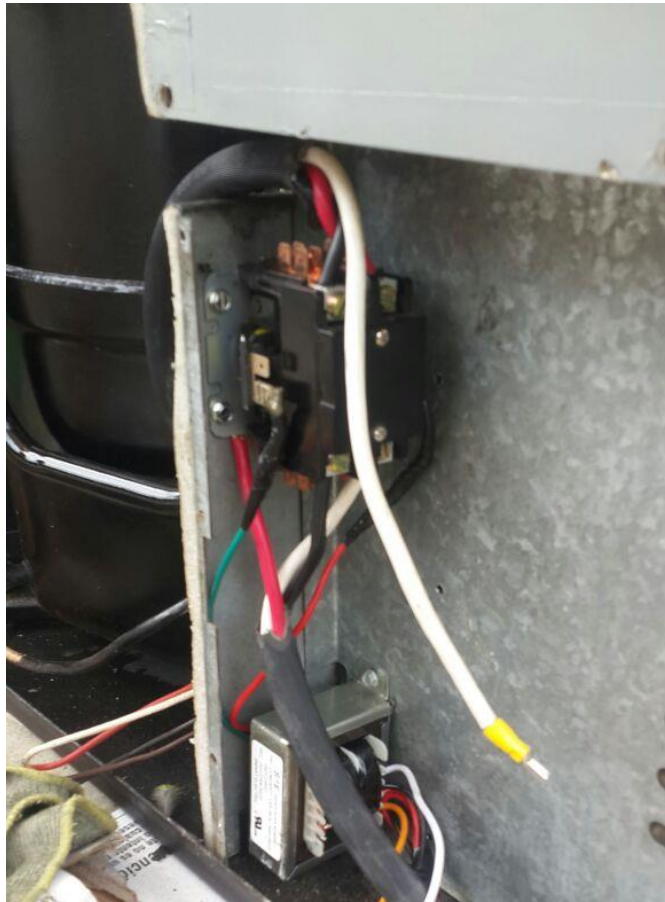
Ilustración 55.-Instalación del nuevo sistema eléctrico
