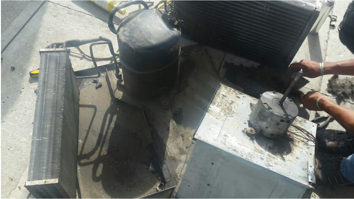
Ilustración 48.- Remoción del aislante dañado de la pared divisoria del evaporador y condensador
