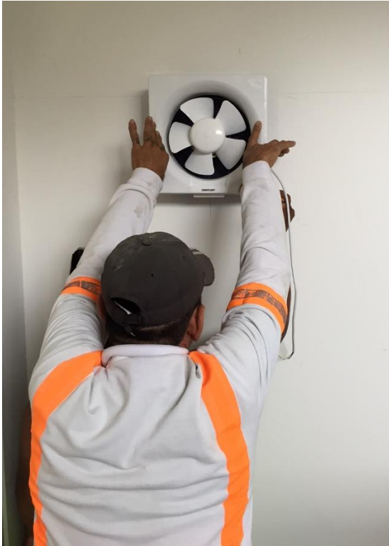
Ilustración 30.- Toma de medidas para los boquetes
