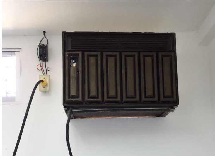
Ilustración 40.- Instalación del equipo
