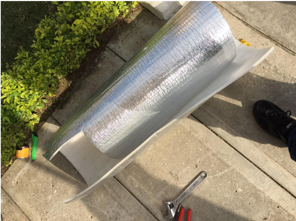
Ilustración 49.- Colocación del nuevo aislante
