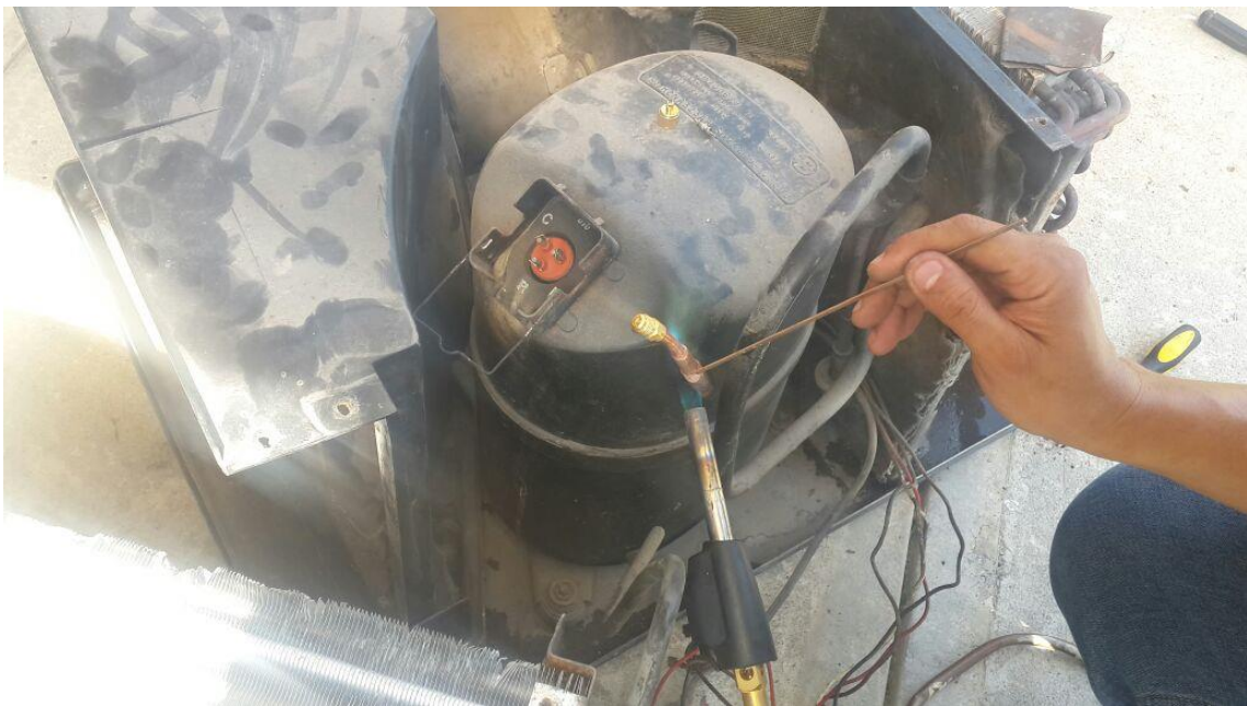
Ilustración 46.- Soldando una válvula al compresor para introducir gas de limpieza
