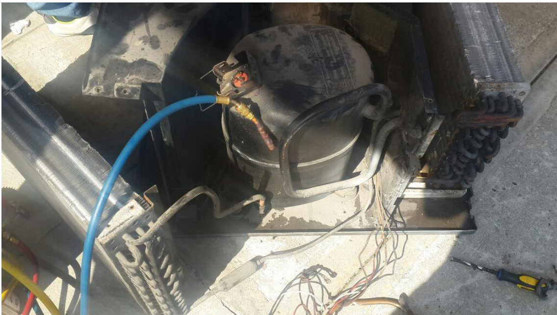
Ilustración 47.- Introduciendo gas de limpieza al compresor
