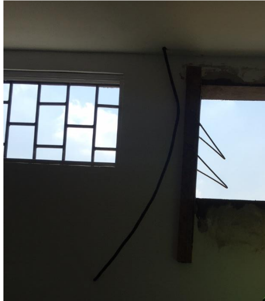
Ilustración 36.- Cable de corriente para la instalación del aire acondicionado
