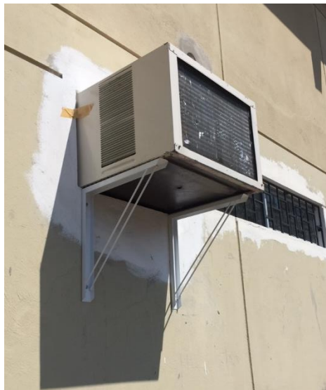
Ilustración 41.- Instalación de soportes
