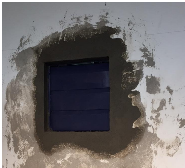
Ilustración 33.- Elaboración de boquete para extractor
