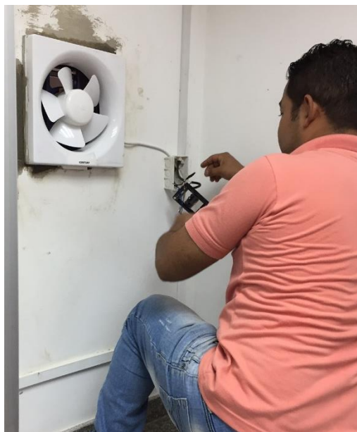
Ilustración 39.- Instalación del switch de los extractores
