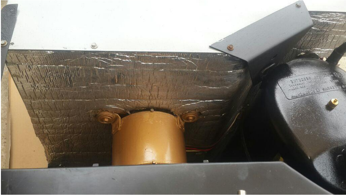
Ilustración 50.- Aislante ya colocado
