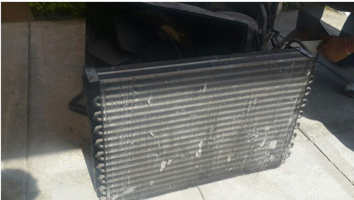
Ilustración 44.- Retiro de la unidad condensadora
