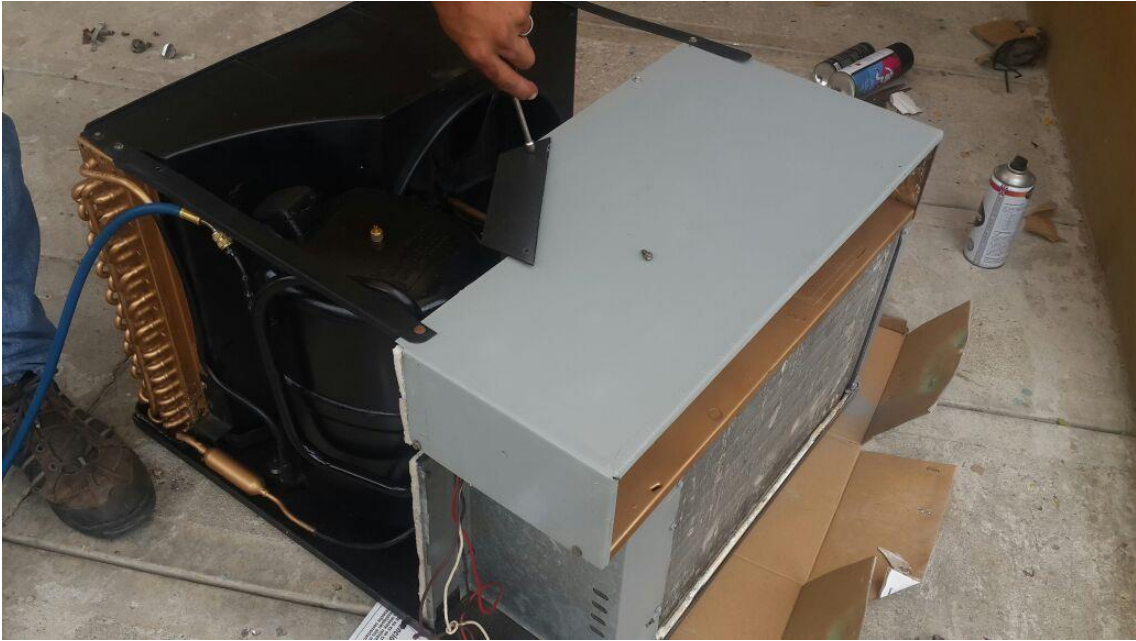
Ilustración 57.- Volviendo a armar el equipo
