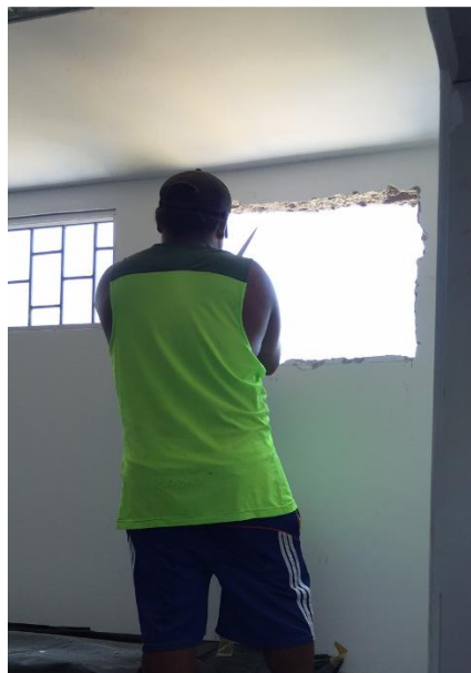
Ilustración 31.- Elaboración del boquete del aire
