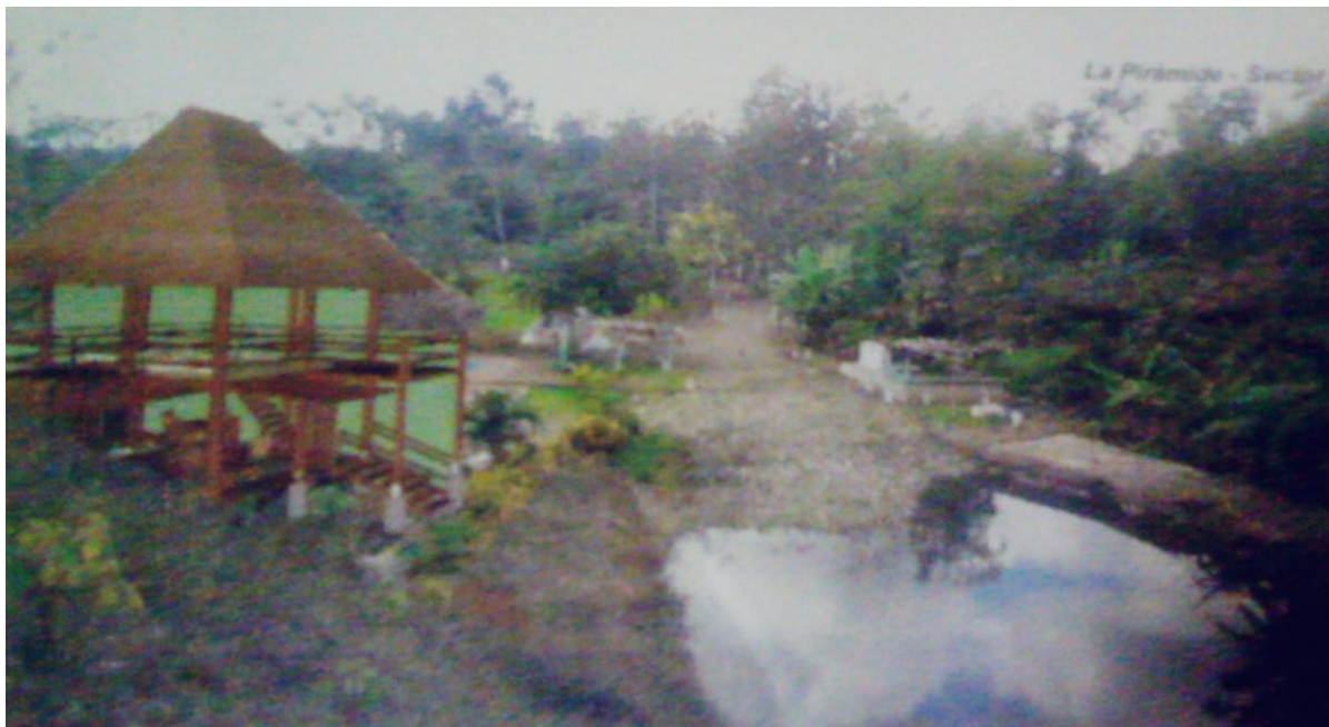
Apéndice M. 8 Cabaña básica en construcción en la finca
