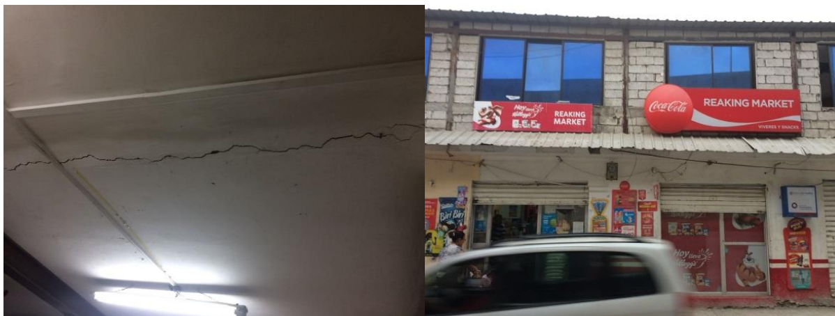
Figura 3.10: Molestias provocadas durante la construcción del puente
