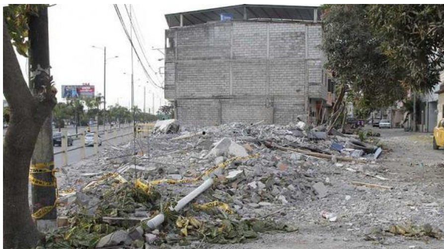
Figura 1.5: Demolición de una de las casas en el Sector del Limonal
