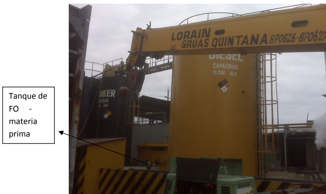
FIG. 4.1– UBICACIÓN DEL TANQUE DE FUEL OIL
