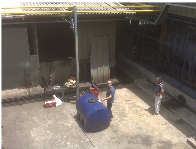
FIG. 4.4 – ÁREA DE EMULSIONES Y TANQUE DE AGUA POTABLE
