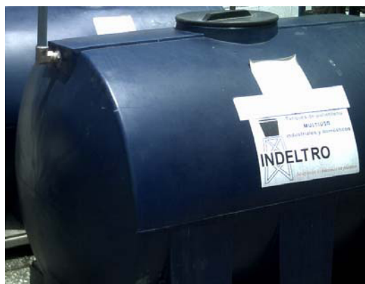
FIG. 4.3 – TANQUE DE AGUA POTABLE
