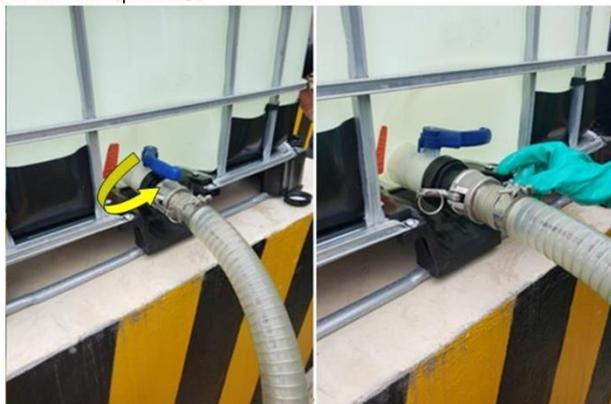
Ilustración 10 Válvula de la boquilla del tanque IBC en OFF
