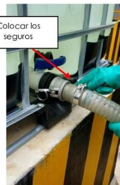
**Ilustración 5** Insertar la manguera a la boquilla y colocar seguros
