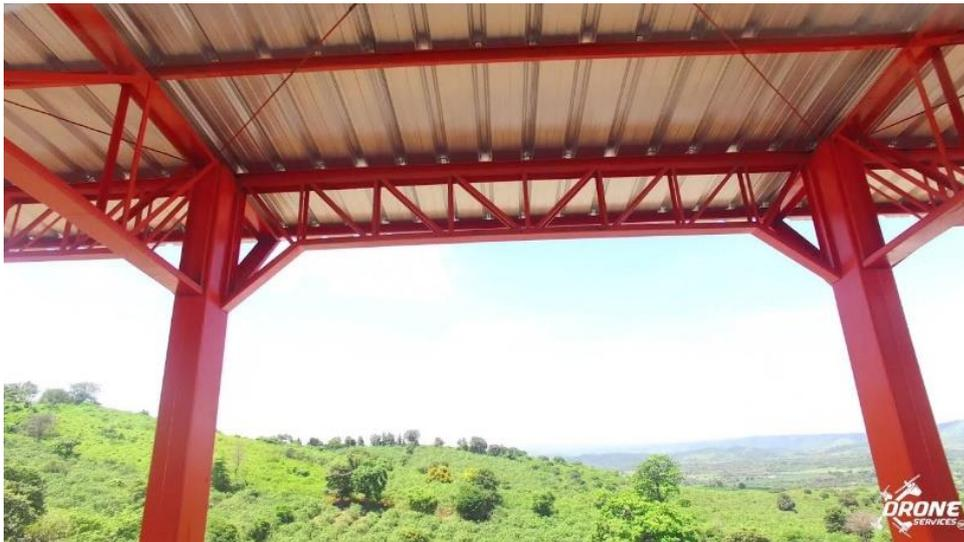
**Figura 2.3 Galpón a dos aguas con viga de amarre**
