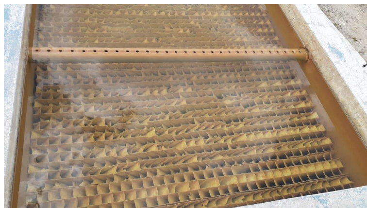
Ilustración 2-7 Sedimentadores con sus respectivas rejillas de la PTAP “El Descanso” [Salcedo & Sevillano, 2020]
