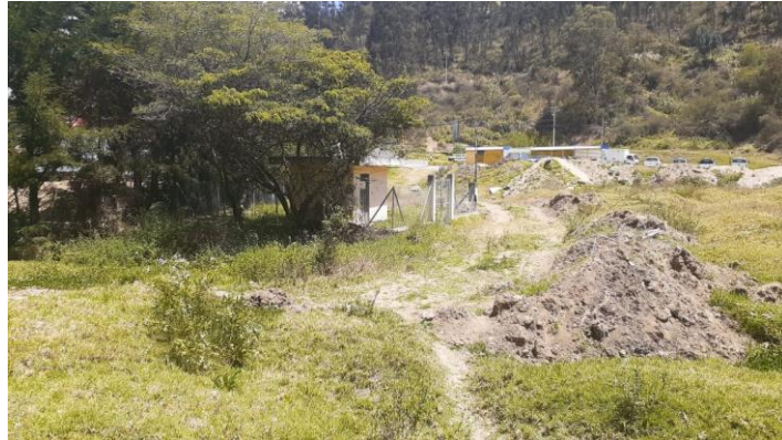
Ilustración 2-1 Vista del cárcamo de bombeo [Salcedo & Sevillano, 2020]
