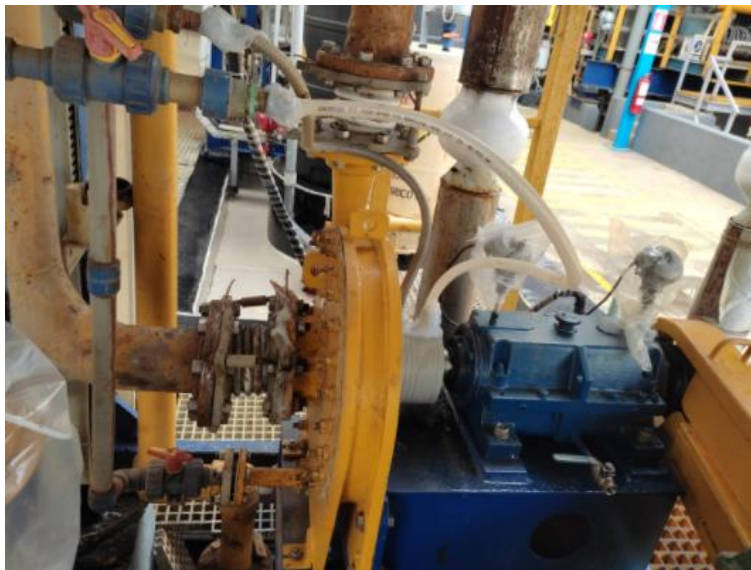
Figura 16. Visualización de sensores de temperatura en la cajera y entrada de aire al sello
