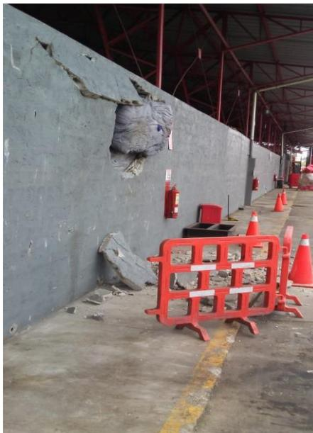
**Figura 1.9. Daño en paredes externas del galpón a causa del peso de bultos y manipulación por empuje del montacargas**
