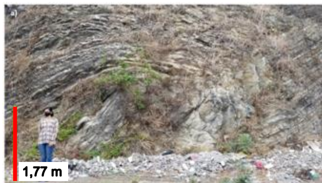
Figura 3.4: Afloramiento de slumps en estación 4 del sector Bellavista.
