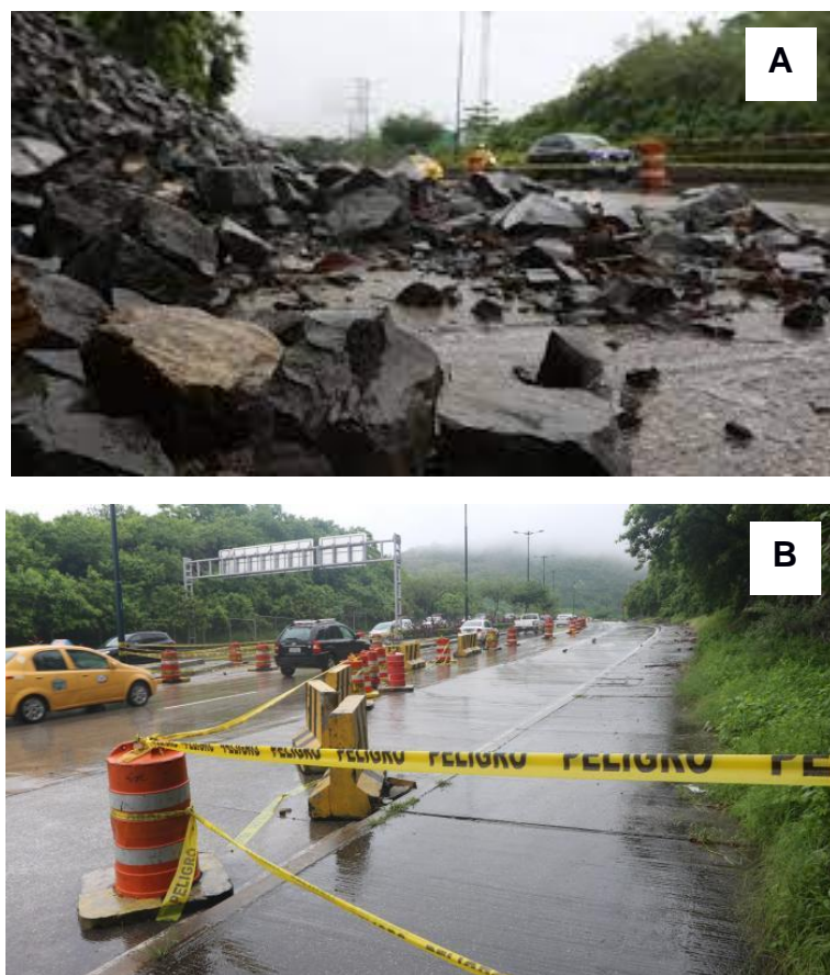
Figura 1.1: Deslizamiento de rocas en vía al túnel San Eduardo. (Sotomayor, 2021)
