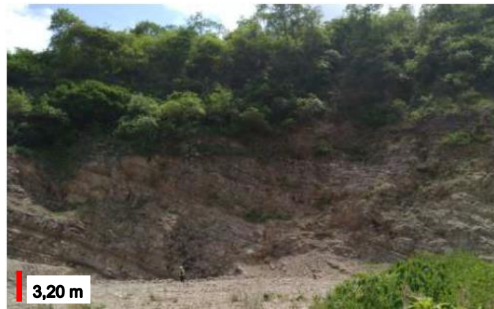
Figura 3.12: Afloramiento en estación 17 del sector Ceibos.
