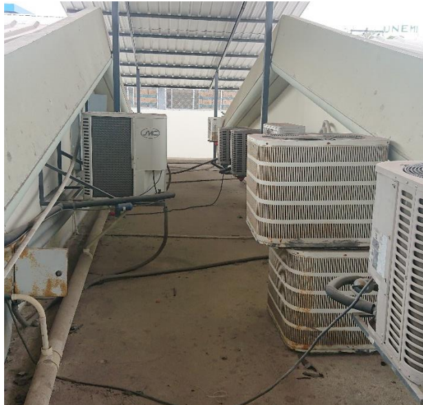
Figura B.11 Conteo de aires acondicionados en los techos de los edificios
