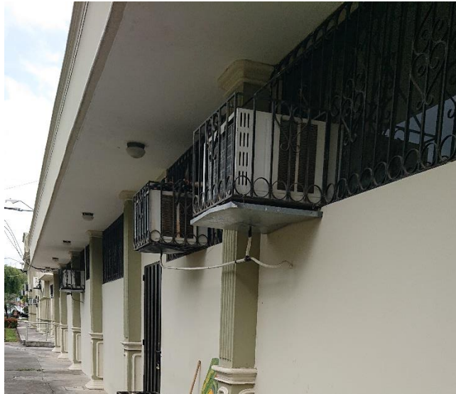
Figura B.12 Conteo de los aires acondicionados de ventana
