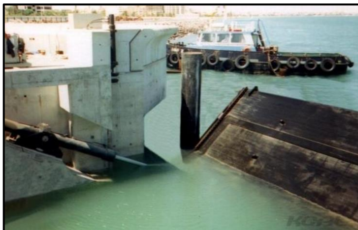
Figura 1.5: Compuerta de bisagra horizontal. (Concepción, 2011)
