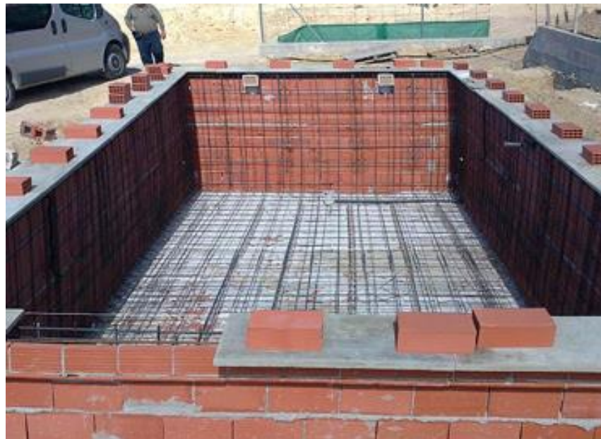
Figura 2.5 Cisterna de hormigón Fuente: (Ibercons Arquitectura, 2016)
