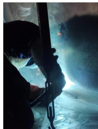
**Figura 3.3 Soldadura con proceso MIG (Elaboración propia).**
