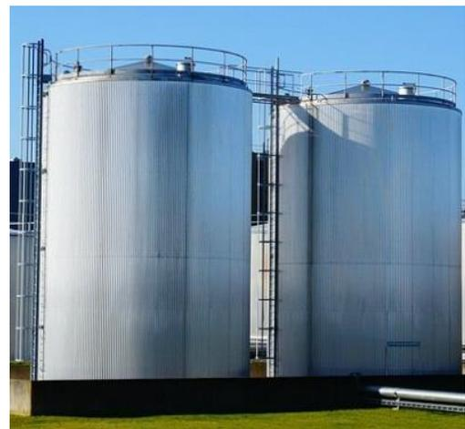
**Figura 1.1 Depósito cilíndrico vertical, fondo plano (CASP, 2021).**
