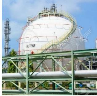
**Figura 1.3 Depósito esférico (ARHENDRIX, 2021).**
