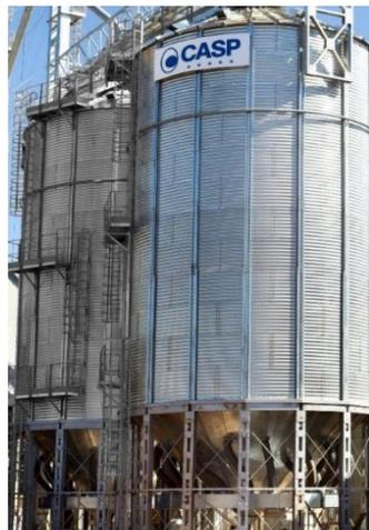
**Figura 1.2 Depósito cilíndrico vertical, fondo cónico (CASP, 2021).**
