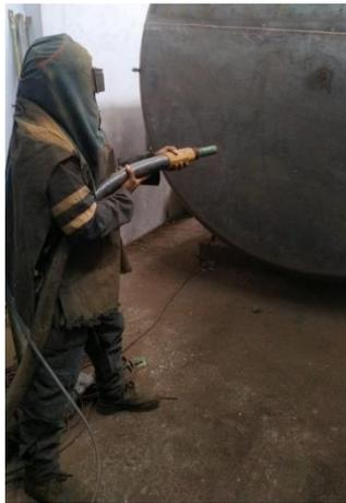
**Figura 3.10 Aplicación de granallado al tanque de almacenamiento (Elaboración propia).**
