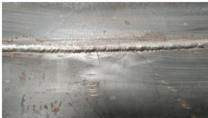
**Figura 3.7 Aplicación de grata en las soldaduras del tanque de almacenamiento (Elaboración propia).**
