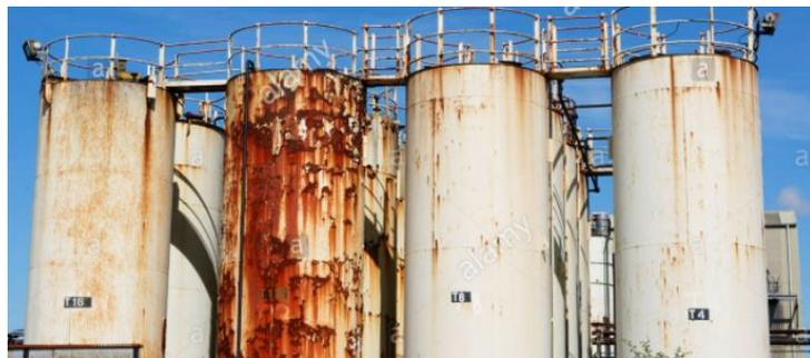
**Figura 1.9 Fallo por Corrosión (Ellison, 2021).**
