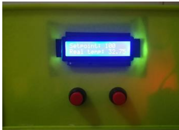
Figura 3.13 Sistema de control vista frontal [Elaboración propia]
