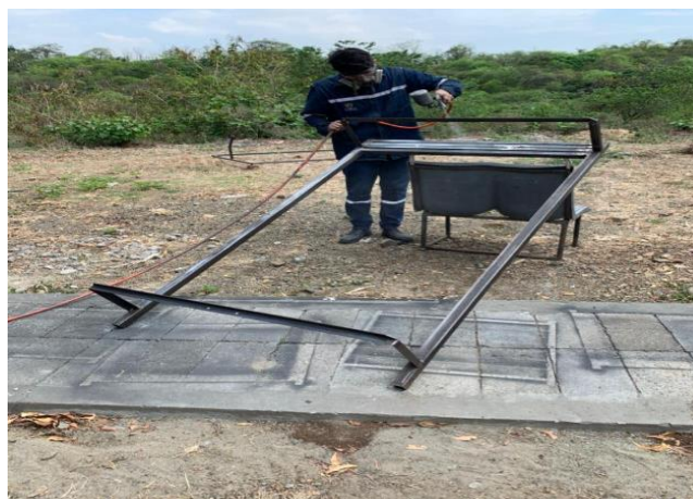
Figura 3. 10 Aplicación de pintura a la base. [Elaboración propia]
