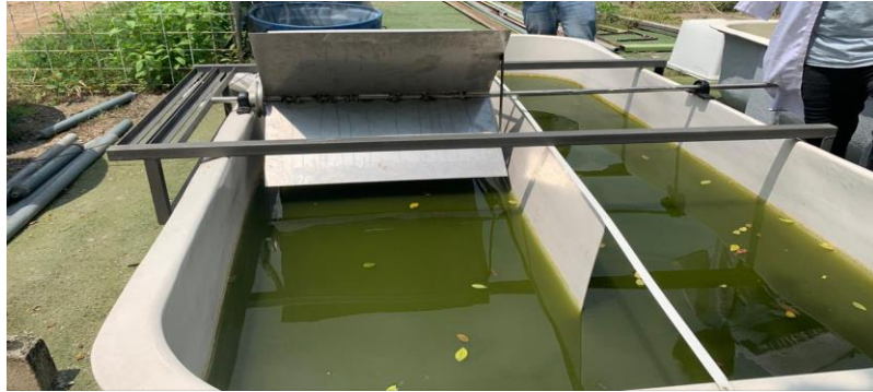
Figura 3. 11 Montaje de los elementos. [Elaboración propia]
