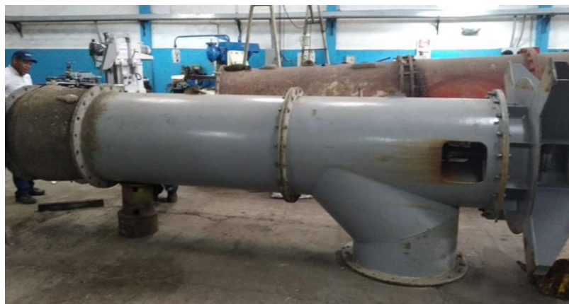
Figura 1.3 Bomba de flujo axial en mantenimiento correctivo.
