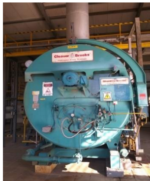
Figura 1.2 Caldera Pirotubular
