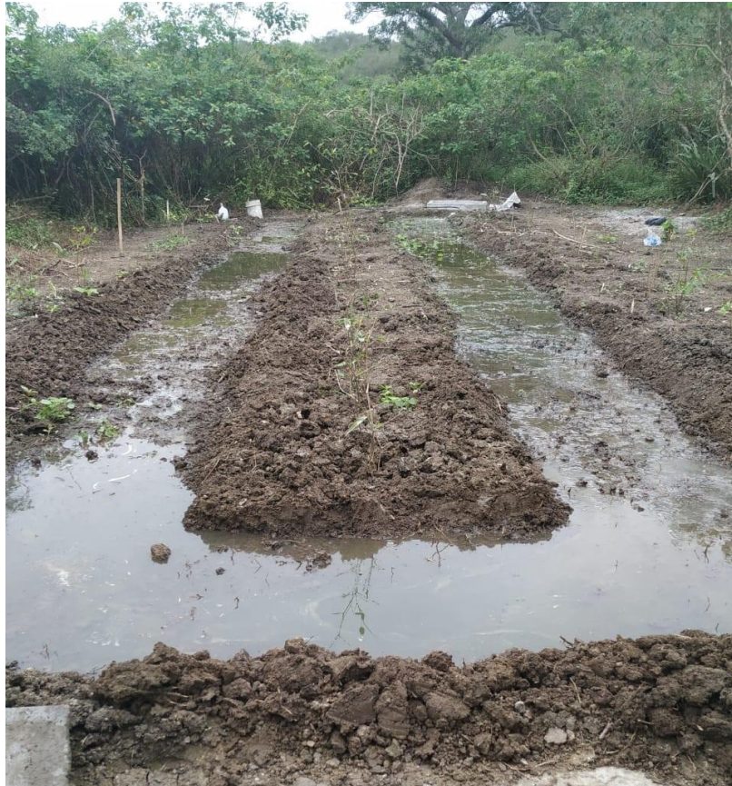
Figura 2.3 Planta piloto de un sistema de filtros verdes en la comuna de Libertador Bolívar. Autores: Parrales & Pozo.
