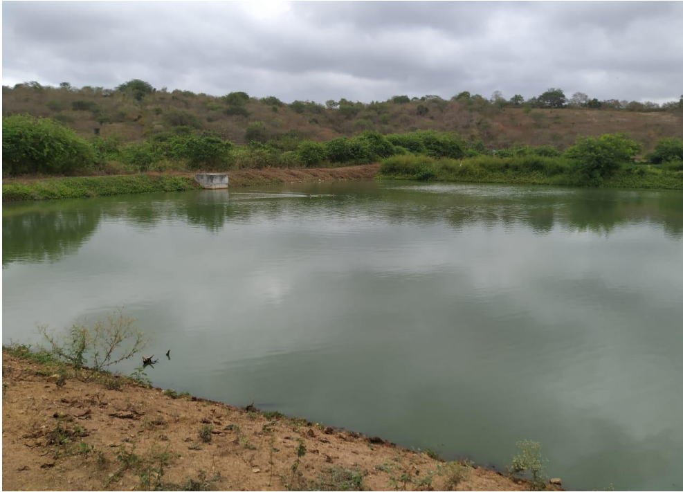
Anexo 1.A. Laguna de oxidación (maduración)
