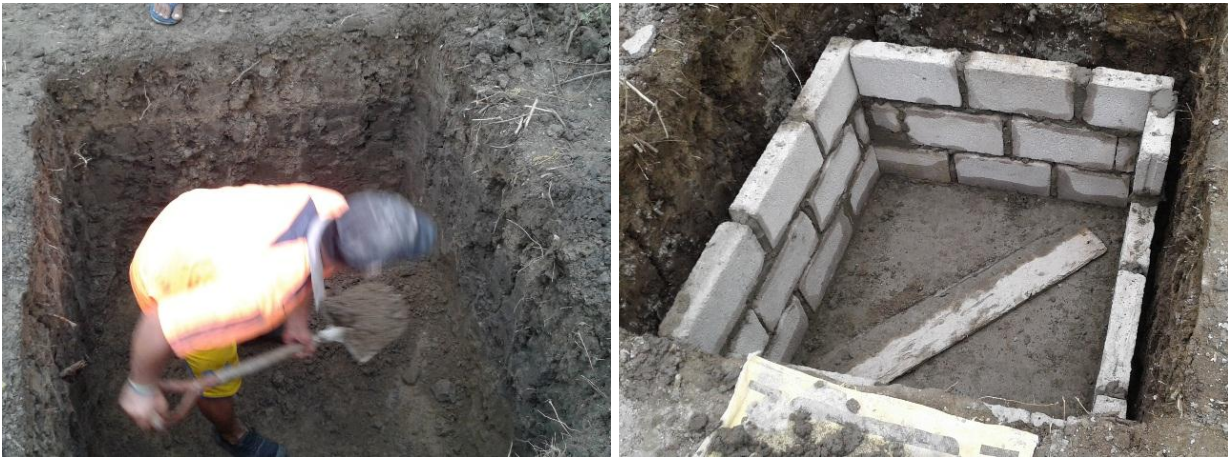
Anexo 2.B. Construcción del lisímetro.
