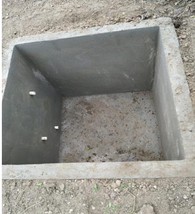
Anexo 2.C. Lisímetro construido
