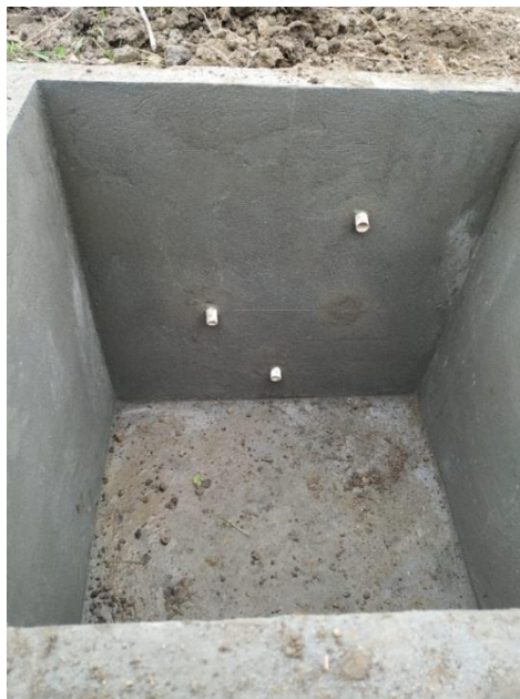
Figura 2.4 Lisímetro utilizado en la planta piloto del sistema de filtros verdes en la comuna Libertador Bolívar. Autores: Parrales & Pozo
