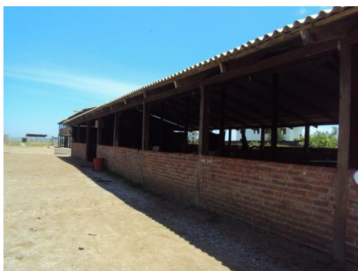
Figura 1. 2 - Instalaciones del Campamento el Faro.
