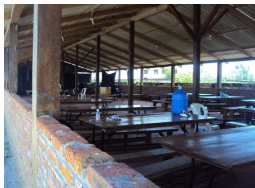
Figura 4. 1 - Instalaciones del Campamento.
