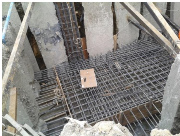
Figura 3.36 Armado de malla superior del cabezal, losa de cimentación (Foto tomada en obra por la autora, agosto 2014)
