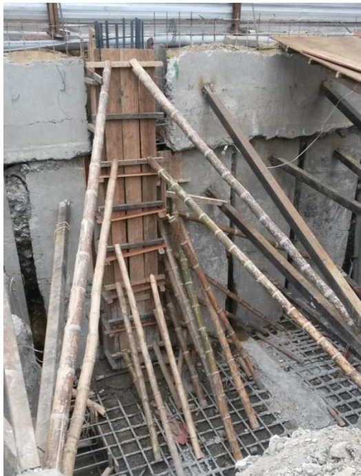
Figura 3.39 Encofrado y apuntalamiento de la columna perimetral. (Foto tomada en obra por la autora, septiembre 2014)
