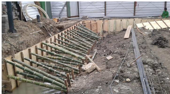
Figura 3.28 Apuntalamiento de encofrado de viga de coronación y pantalla (Foto tomada en obra por la autora, julio 2014)
