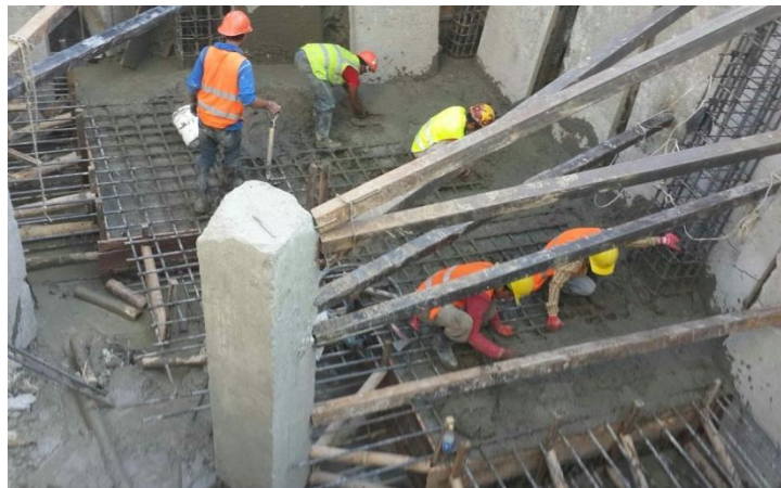
Figura 3.37 Fundición de la losa de cimentación. (Foto tomada en obra por la autora, agosto 2014)
