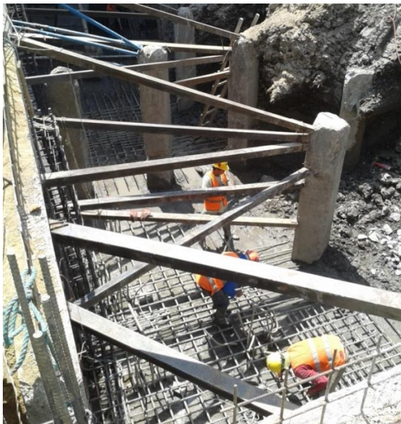
Figura 3.33 Armado de malla inferior del cabezal, losa de cimentación (Foto tomada en obra por la autora, agosto 2014)
