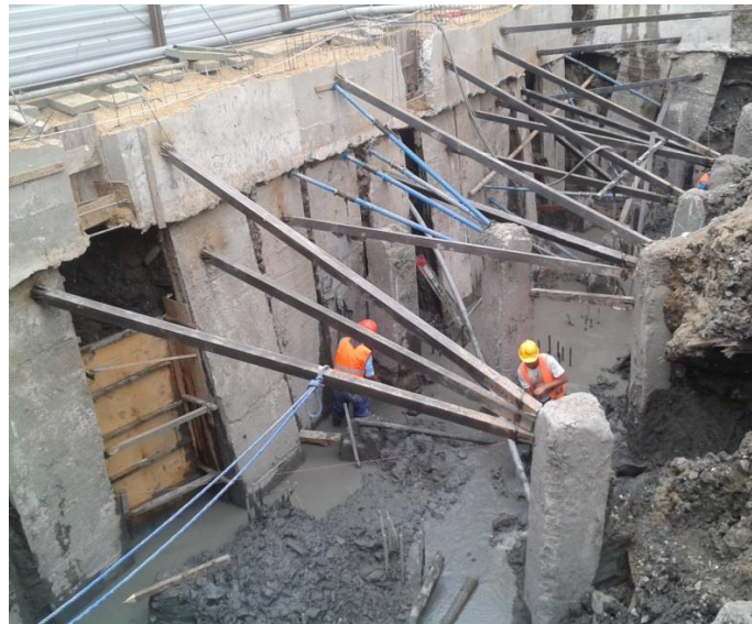
Figura 3.32 Apuntalamiento de tablestacas y pantallas. (Foto tomada en obra por la autora, agosto 2014)
