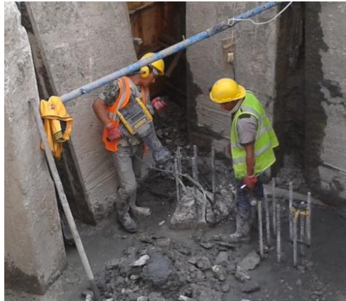
Figura 3.31 Picado de pilotes. (Foto tomada en obra por la autora, agosto 2014)
