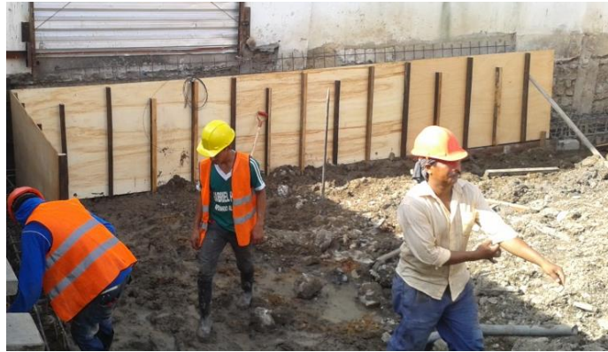
Figura 3.27 Encofrado de viga de coronación y pantalla. Vista superior (b) Vista frontal (Foto tomada en obra por la autora, julio 2014)
