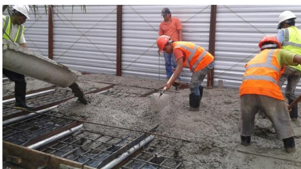
Figura 3.23 Encofrado y fundición de tablestaca. (Foto tomada en obra por la autora, mayo 2014)
