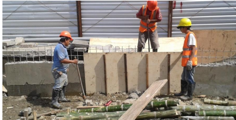
Figura 3.29 Desencofrado de viga de coronación y pantalla. (Foto tomada en obra por la autora, julio 2014)
