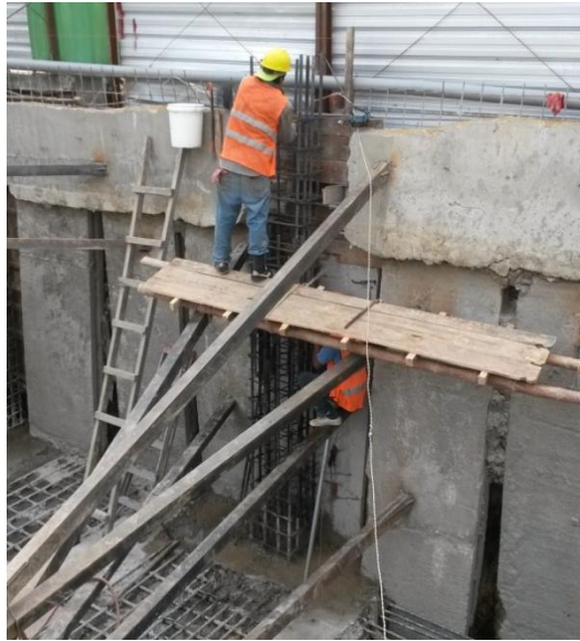
Figura 3.38 Traslape de columna perimetral. (Foto tomada en obra por la autora, septiembre 2014)
