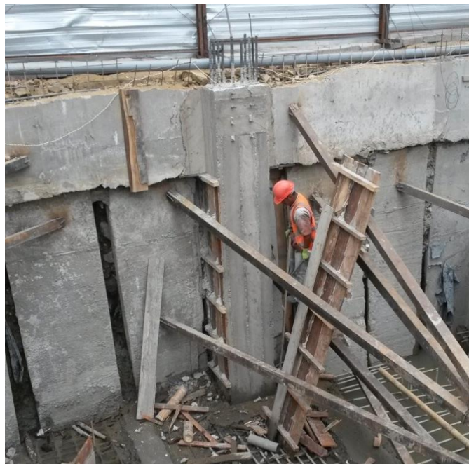
Figura 3.40 Desencofrado de columna perimetral. (Foto tomada en obra por la autora, septiembre 2014)
