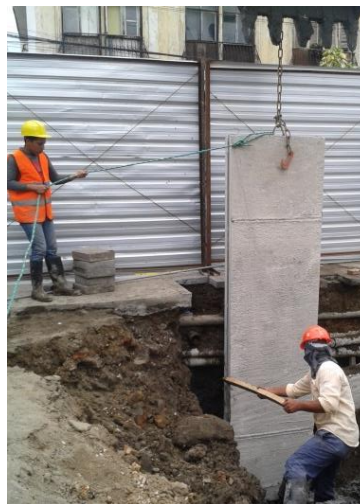
Figura 3.25 Hincado de tablestaca. (Foto tomada en obra por la autora, junio 2014)
