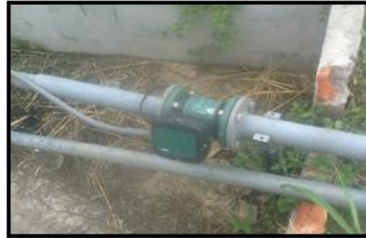
Colocación de sensor de caudal en estación de bombeo del BIMESM
