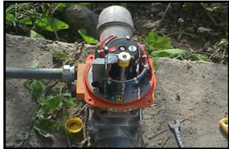
Desmontaje del actuador de la estación de bombeo
