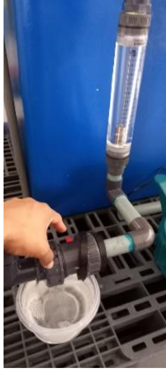
Figura D.41 Prueba de las válvulas de retención estación 1
