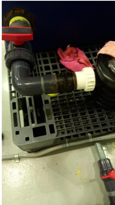
Figura D.6 Instalación de línea de succión.
