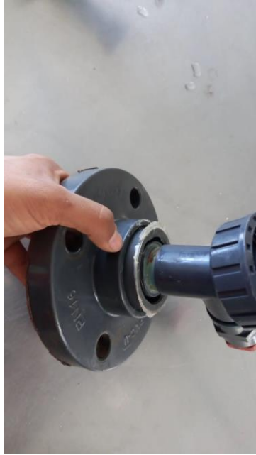
Figura D.16 Encolado de partes con cemento solvente para PVC.
