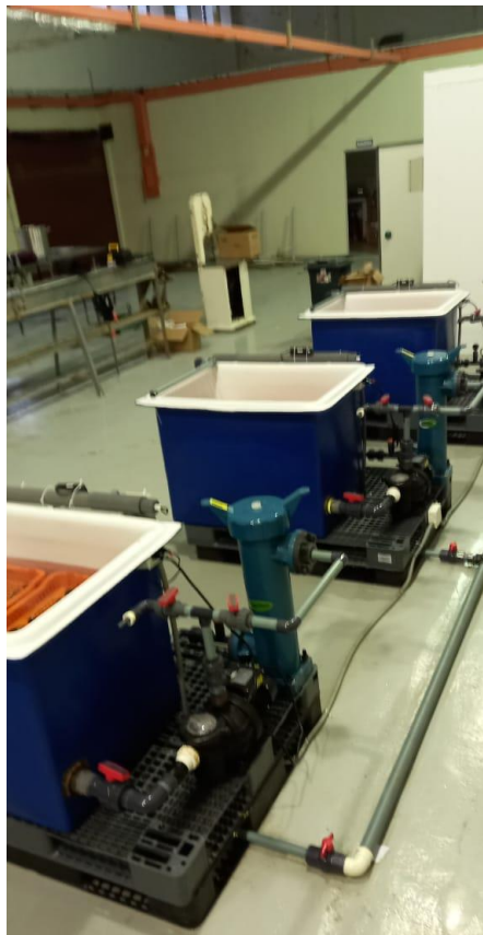
Figura D.26 Instalación de la tubería de desagüe.
