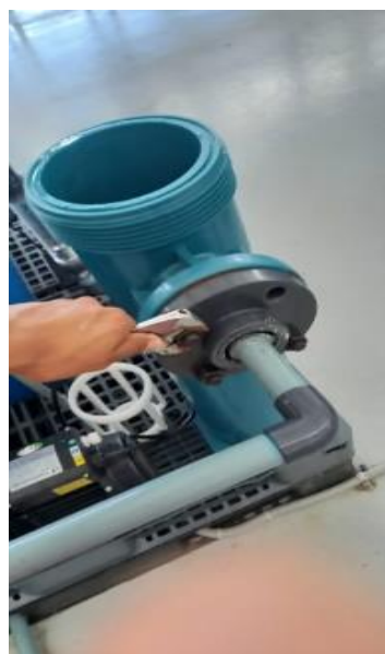
Figura D.21 Instalación de línea de entrada al filtro para sedimentos
