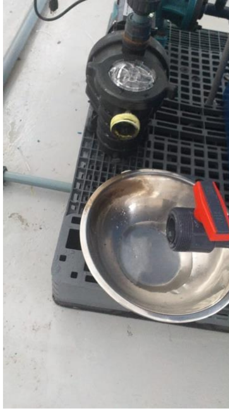
Figura D.10 Revisión de líneas de succión
