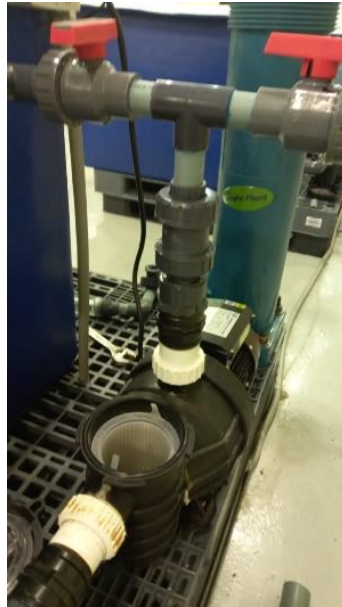
Figura D.7 Instalación de línea de impulsión
