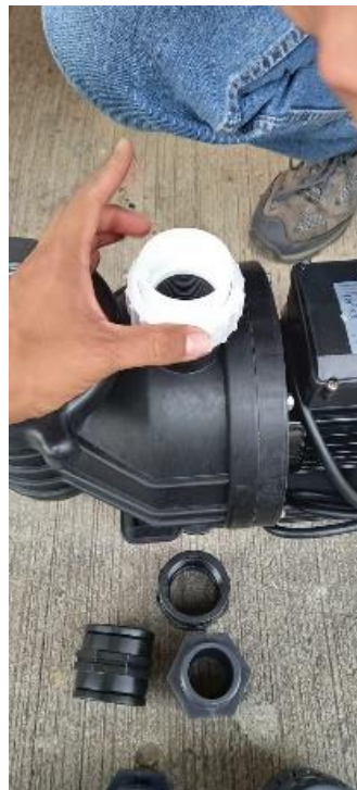
Figura D.2 Instalación de la bomba
