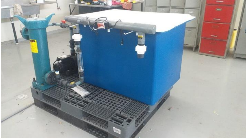
Figura D.22 Instalación de rotámetro y UV.
