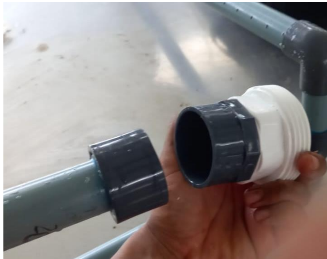
Figura D.17 Encolado de partes PVC.
