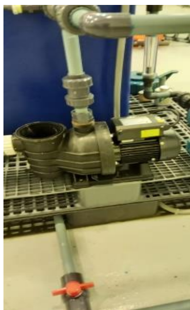
Figura D.40 Verificación de las líneas de evacuación de agua de los sedimentos.
