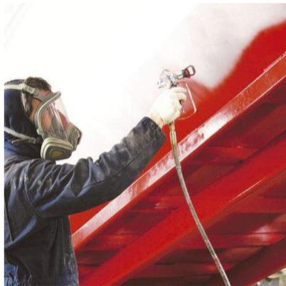
**Figura 1.4 Aplicación de pintura por aspersión airless**
