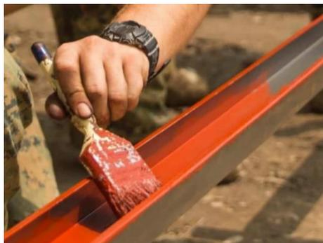
Figura 1.1 Aplicación de pintura con brocha
