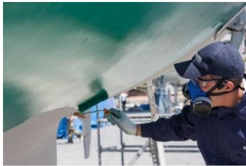
**Figura 1.2 Aplicación de pintura con rodillo**
