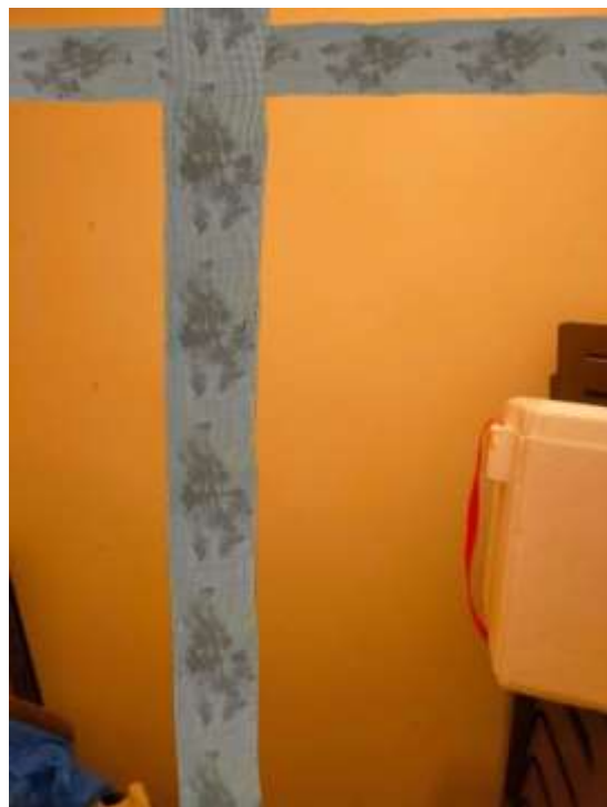
Ilustración 24 Rehabilitación Problema leve 1
