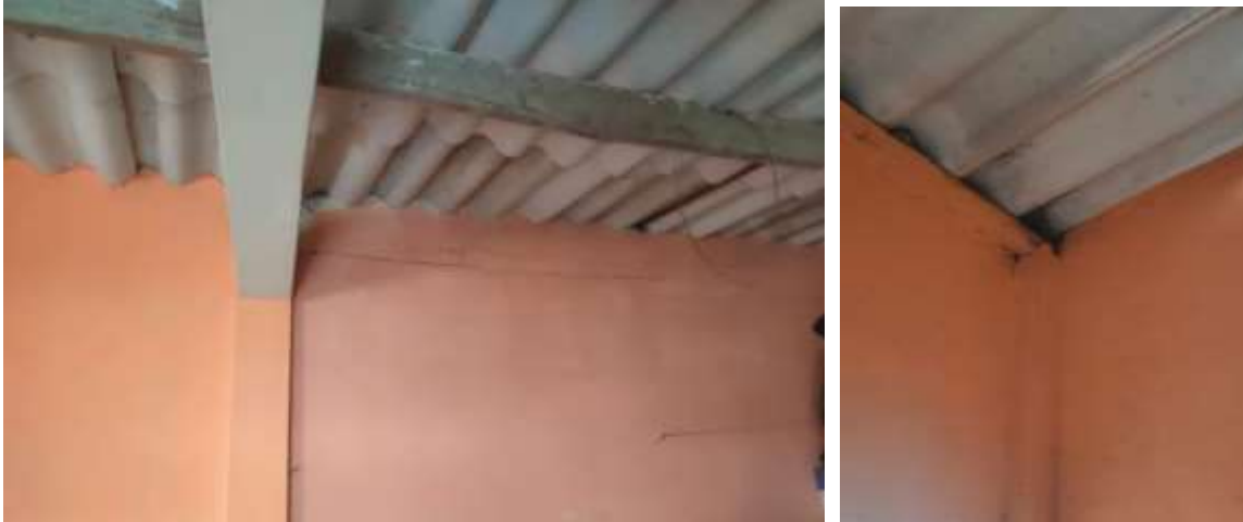
Ilustración 12 Construcción mixta con vigas de madera - Terraza
