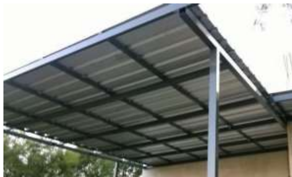
Ilustración 27 Rehabilitación problema leve 3 (Hierrosmolina.com, 2016)
