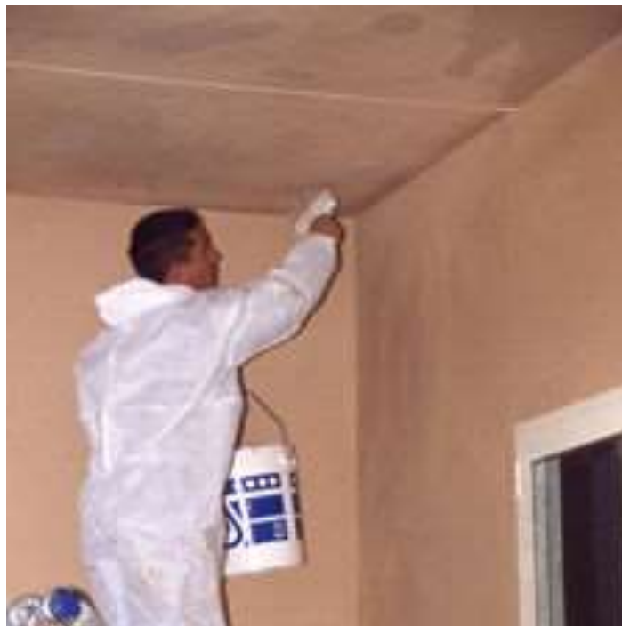
Ilustración 26 Rehabilitación problema leve 2 (archiexpo.es/impermeabilizante, 2012)
