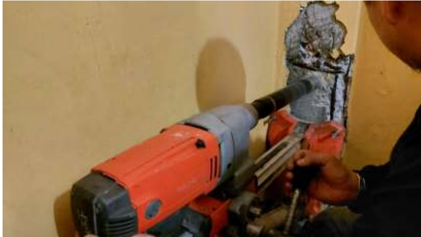
Ilustración 16 Proceso de extracción de núcleo.
