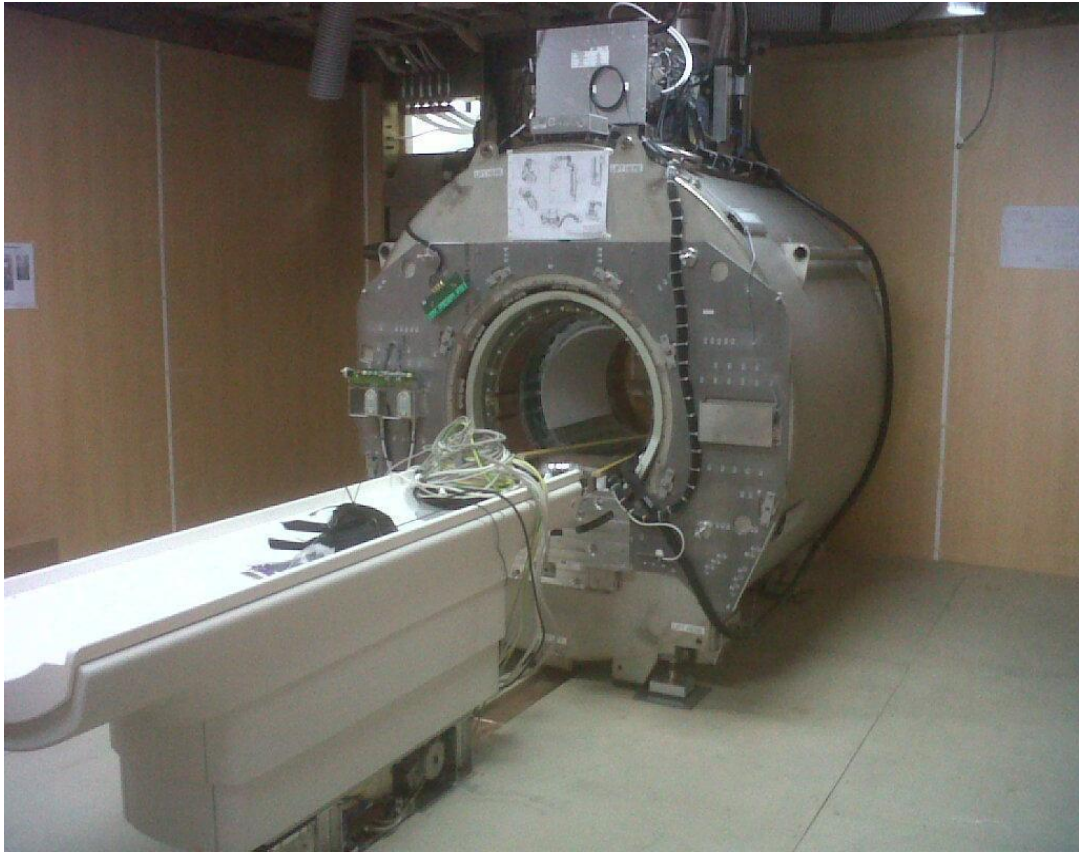
Figura 4.23 Instalación del resonador
