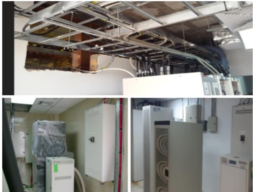
Figura 4.29 Instalación cuarto de máquinas
