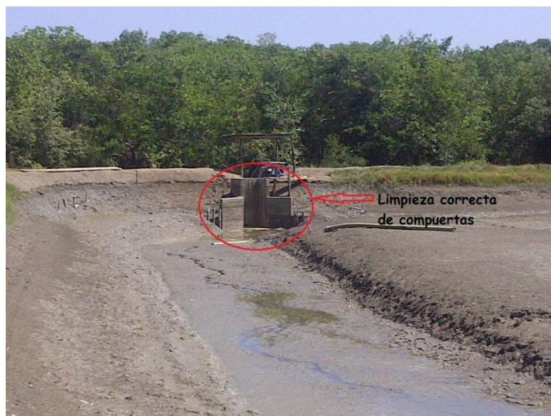
Imagen 9-Limpieza total de las compuertas de evacuación de las piscinas camaroneras
