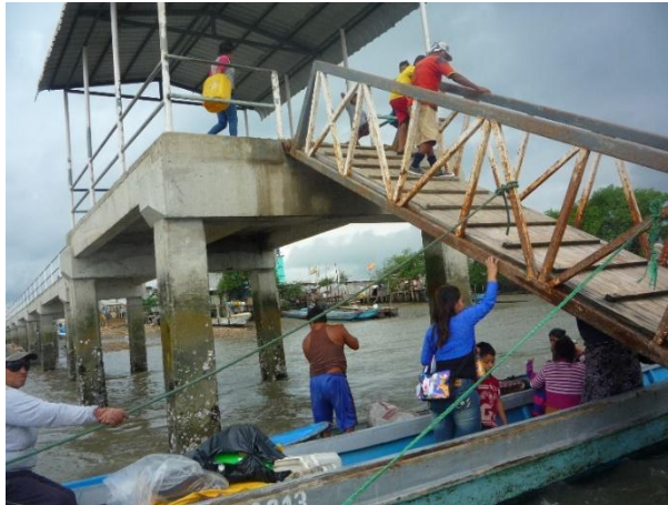
Imagen 6-Llegada de lanchas al muelle de hormigón con las personas trepando por las escaleras 2017
