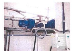
**Figura 6:** Blower – fuente de aireación general
