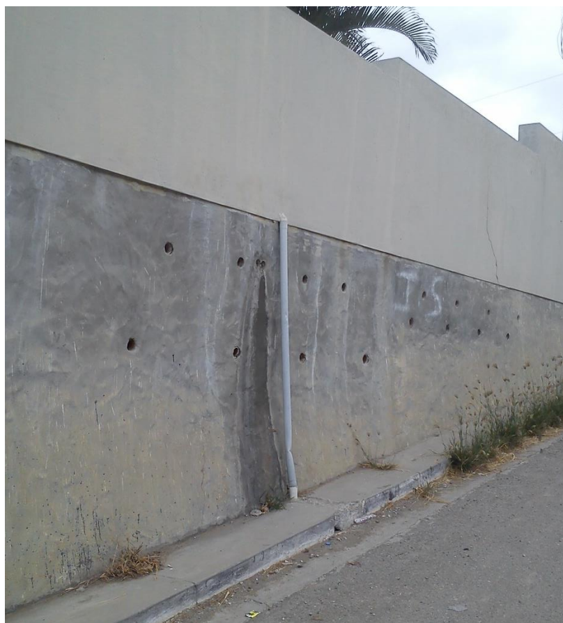
Imagen 2. 7 CONEXIÓN DE AGUAS SERVIDAS
