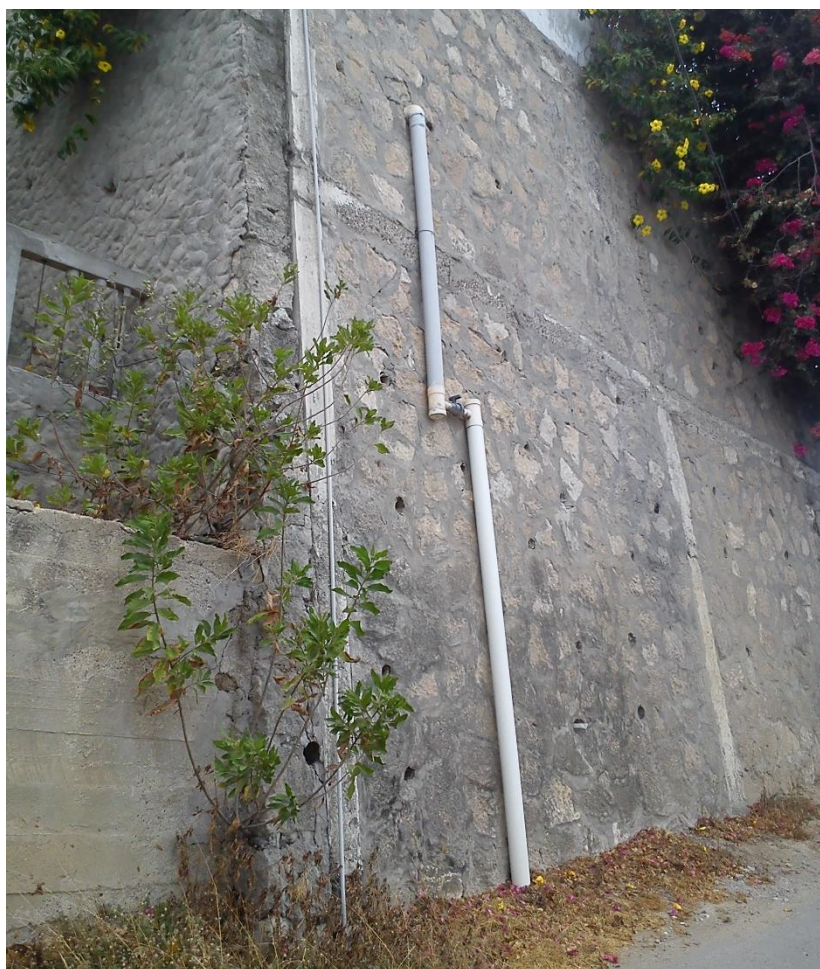
Imagen 2. 8 CONEXIÓN DE AGUAS SERVIDAS
