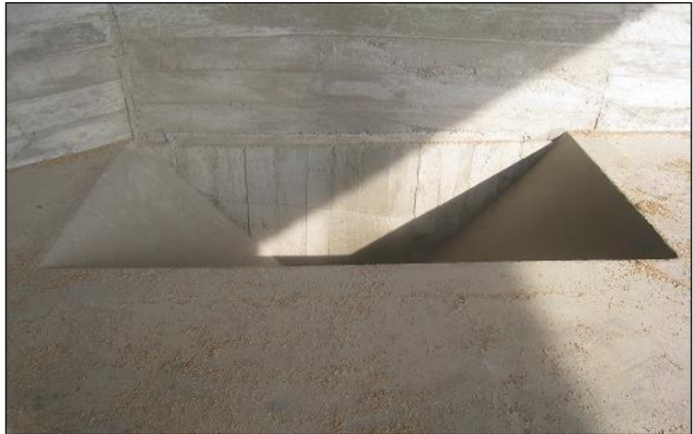
Figura 3.2 Tolva de concreto a nivel del piso.
