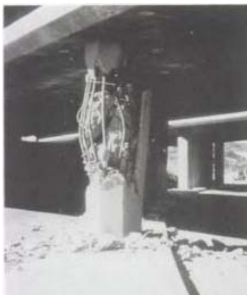
Figura 3.24: Falla a cortante fuera de la región de la articulación plástica en el sismo de San Fernando. (Tomada de Priestley, Seible y Calvi, 1996)
