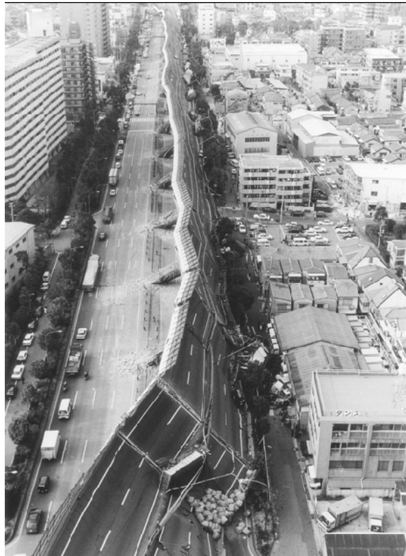
Figura 3.22: Falla por flexión arriba de la base de las columnas de la autopista Hanshin, debido a la terminación prematura del refuerzo longitudinal y falta de confinamiento durante el sismo de Kobe. (Tomada de Priestley, Seible y Calvi, 1996)
