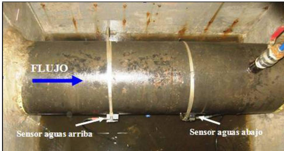
Fotografía 11. Instalación de sensores tipo "clamp-on" sobre una tubería de 350mm AC según método de instalación en "V", para un caudalímetro ultrasónico Polysonics DCT6088 (Thermo). Punto de macromedición CTP-064-M40 ubicado en calle 38 y R. Avilés.
