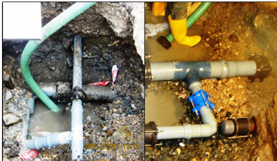
Fotografías 3 y 4. Empate (izquierda) y taponamiento (derecha) ejecutados para adaptar la red de distribución de AA.PP. a los límites de la sectorización hidráulica
