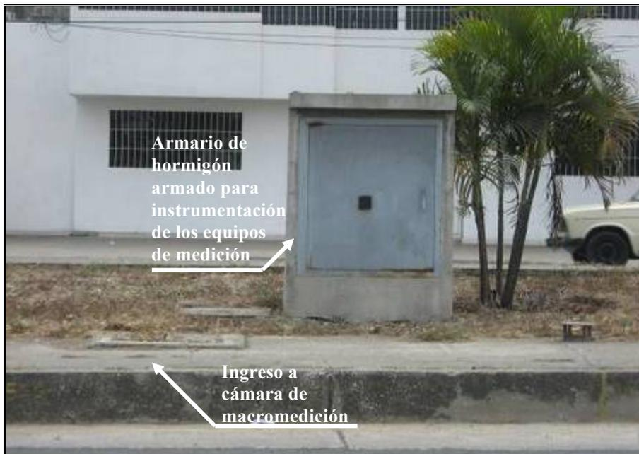
Armario de hormigón armado para instrumentación de los equipos de medición
