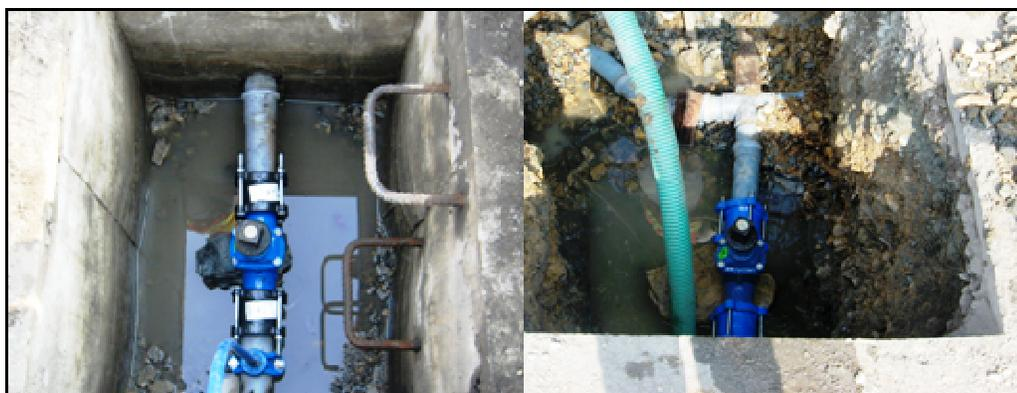
Fotografías 1 y 2. Reemplazo (izquierda) e instalación (derecha) de válvulas de  $\phi 90\text{mm}$  tipo compuerta.
