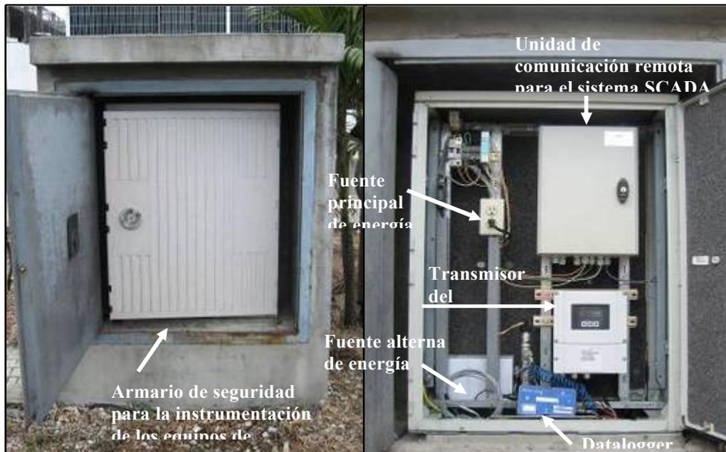
Unidad de comunicación remota para el sistema SCADA
