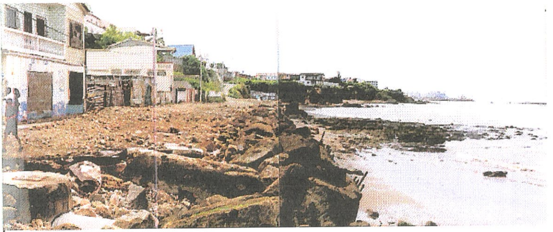
Figura3.14a. Daños ocasionados por El Niño 1997-1998 en La Libertad
