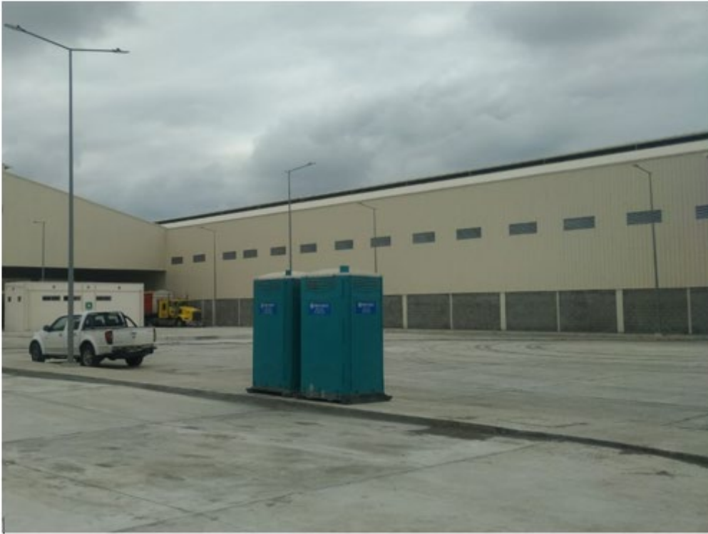
Ilustración 1. Cerramiento de taller de soldadura para bombas axiales para camaroneras.
