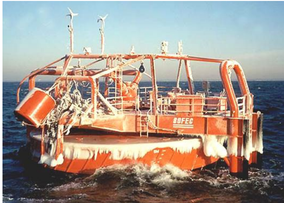
FIGURA 1.5. SISTEMA DE AMARRE POR MONOBOYA TIPO CALM.
