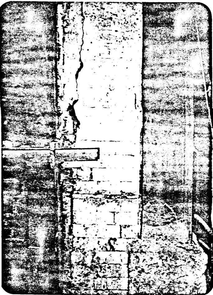
FOTO #4, FISURA PARED DELANTERA, CALD. #3
