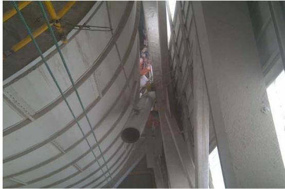
**FIGURA 5.11 - ENSAMBLE DE DUCTOS PARA TRANSPORTE DE ARENA**
