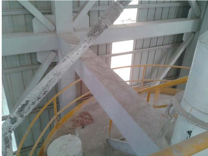
**FIGURA 5.4 - VIGA CAJÓN CENTRAL FINALIZADA**
