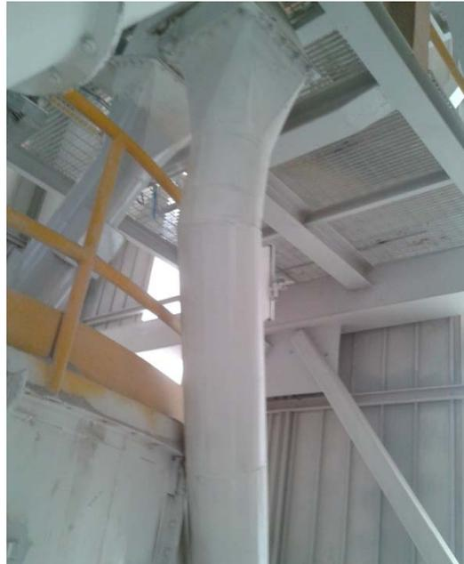
**FIGURA 5.13 - ÚLTIMO TRAMO DE DUCTO ENSAMBLADO.**
