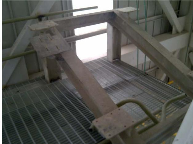
**FIGURA 5.8 - BANCADA DEL EQUIPO VIBRATORIO CRIBA**
