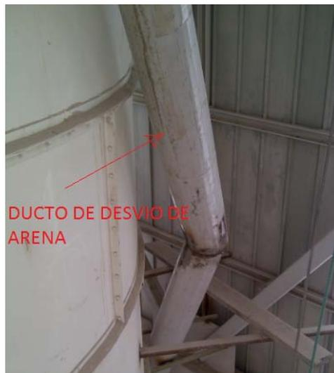
**FIGURA 5.12 - ENSAMBLE DE DUCTOS INTERMEDIO PARA TRANSPORTE DE ARENA.**
