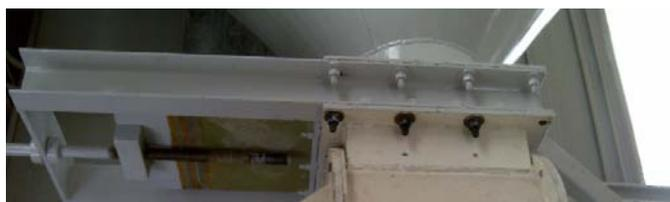
**FIGURA 5.16 - VÁLVULA GUILLOTINA COMPLETAMENTE INSTALADO.**
